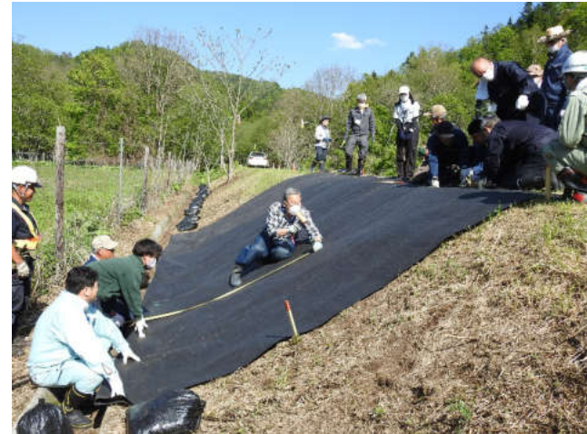
防草シート敷設の様子
