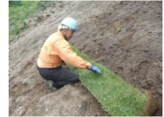
ロール芝の敷設
