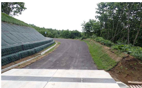
林業生産基盤整備道ワッカ美加登線（林道）：土幌町
