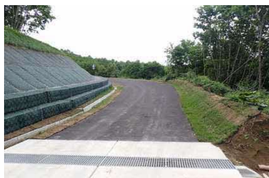
林業生産基盤整備道ワッカ美加登線（林道）：土幌町
