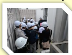
【バイオガス分離ユニット】
