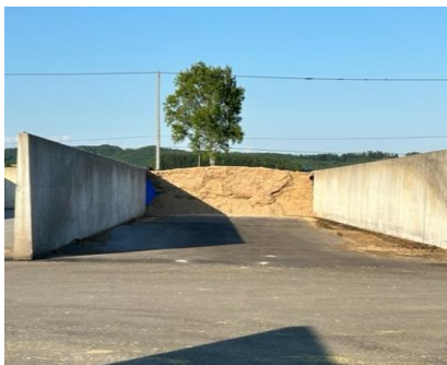
写真2 舗装されたバンカーサイロ周辺
