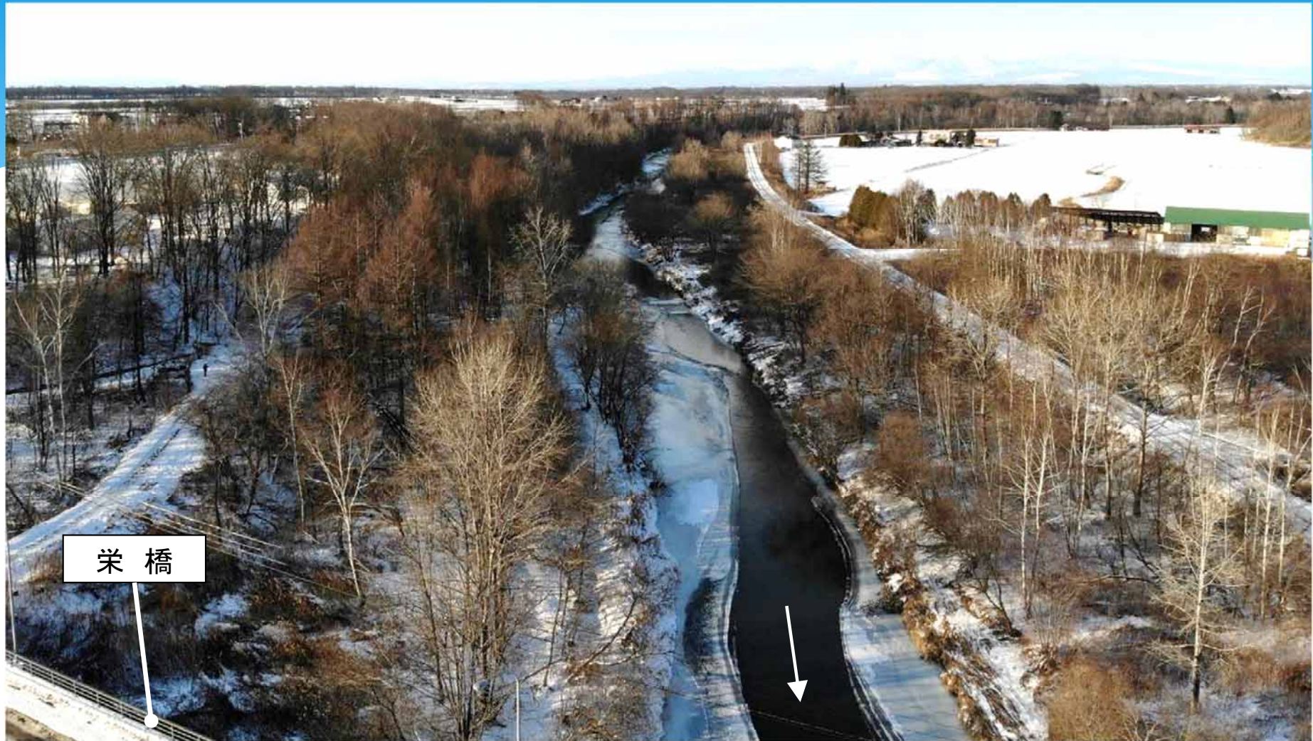
土幌川：伐採前の状況(R4.12.21)
