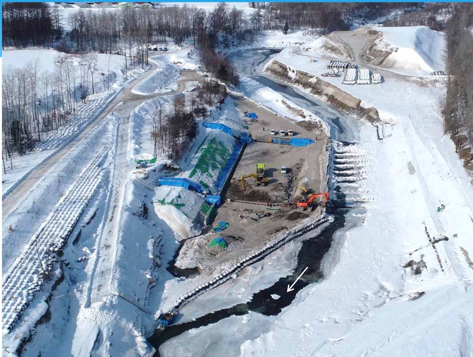
然別川総合流域防災工事 施工箇所状況(R5.2.1)
