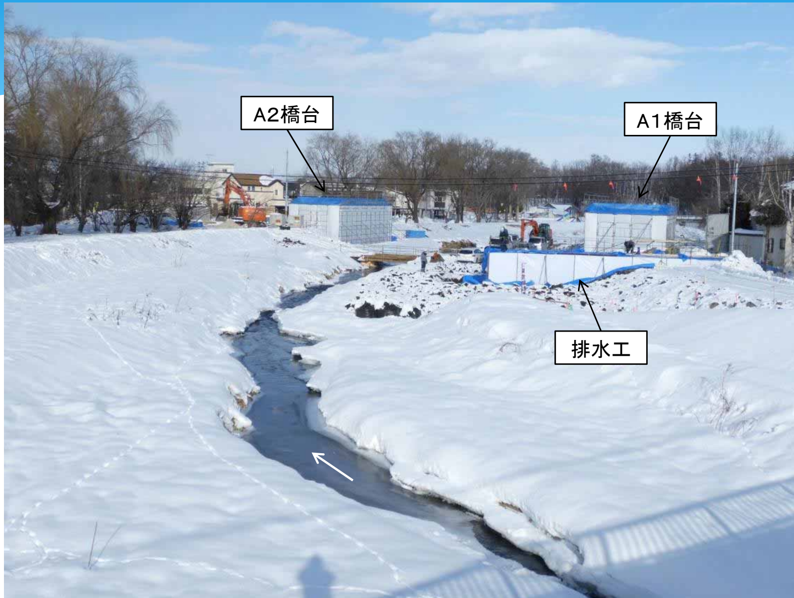
ピウカ橋下部工と改修工事施工箇所状況 (R5.1.17)
