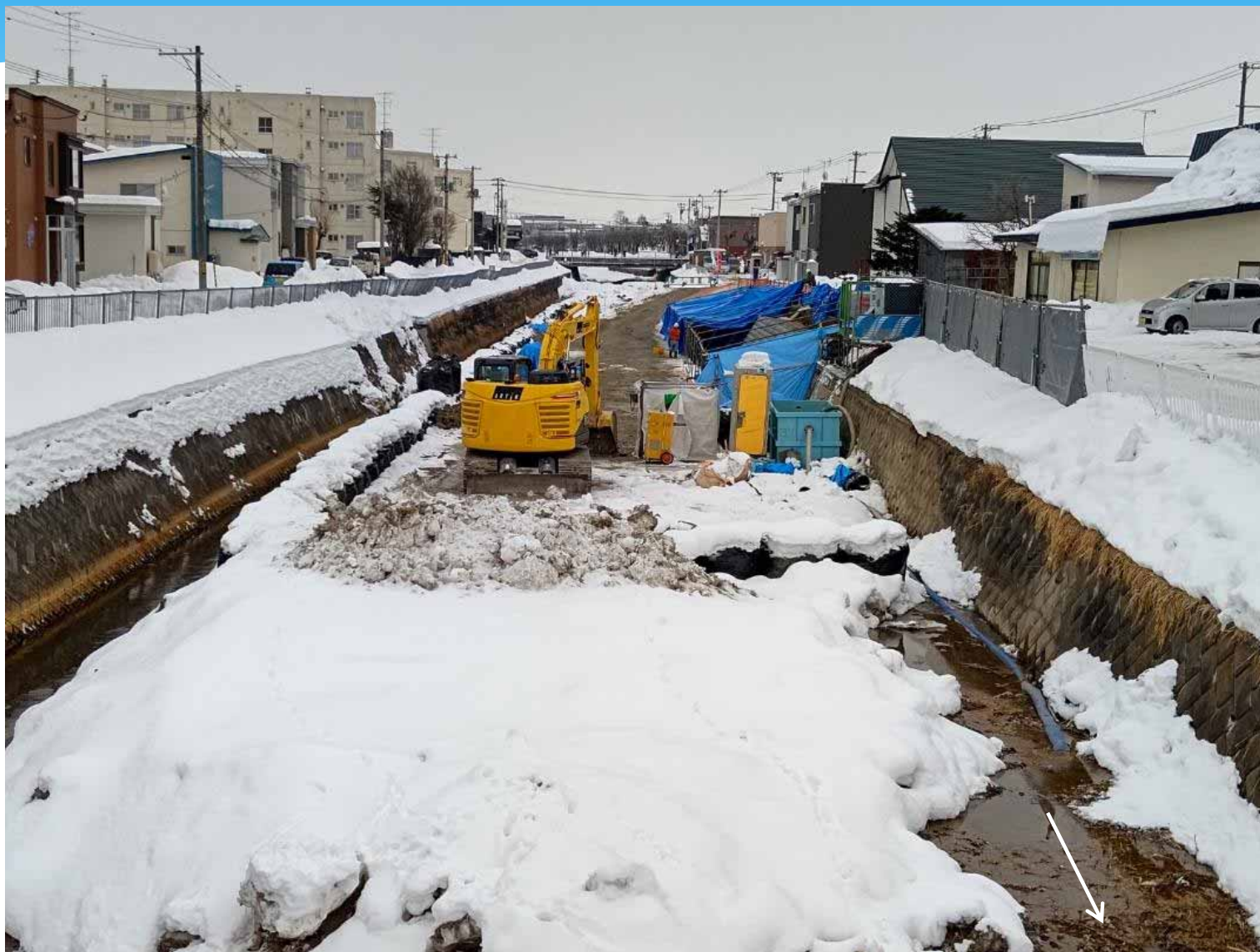
中駒橋上流 施工状況(R5.2.1)
