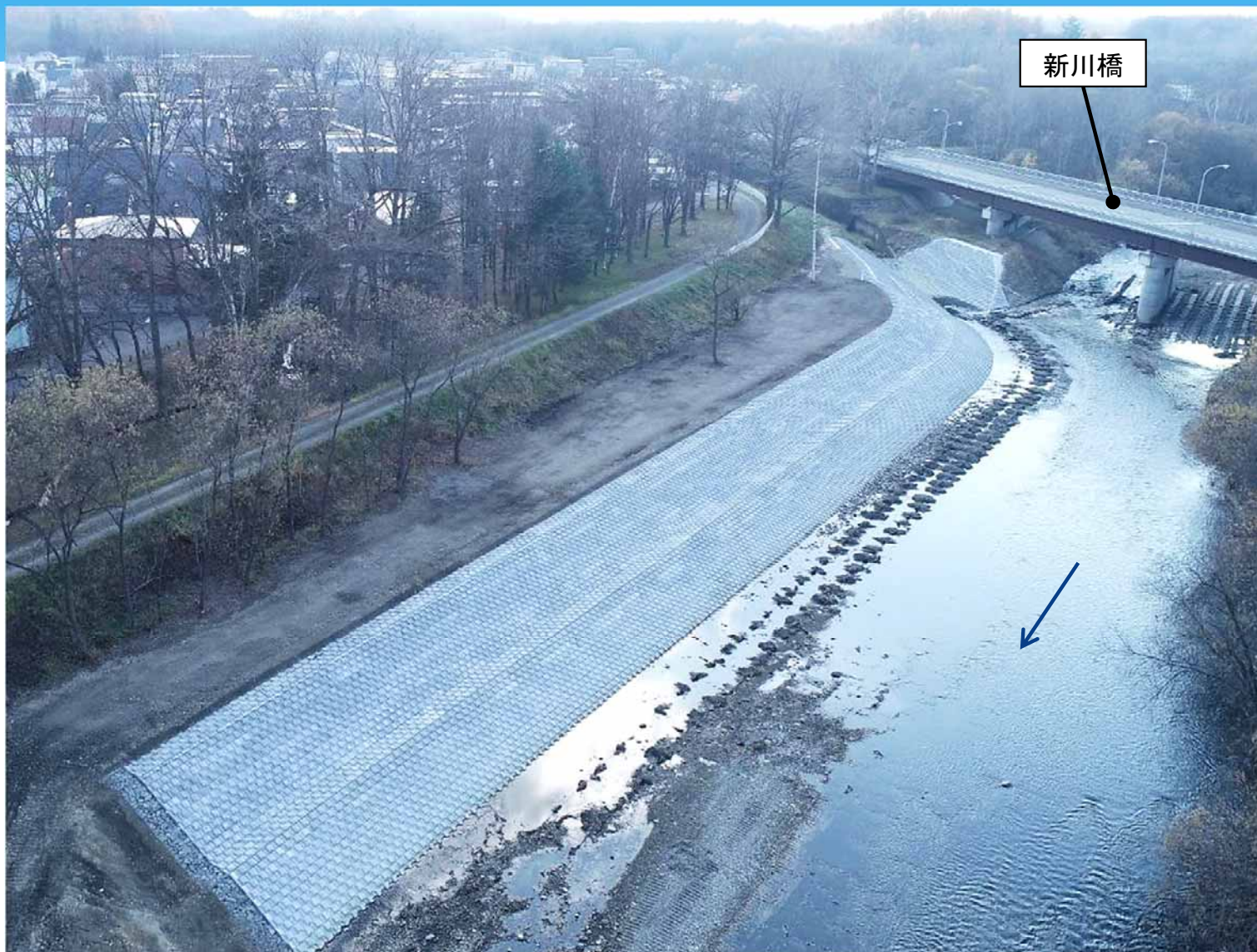
新川橋下流 施工箇所(R4.11.9)
