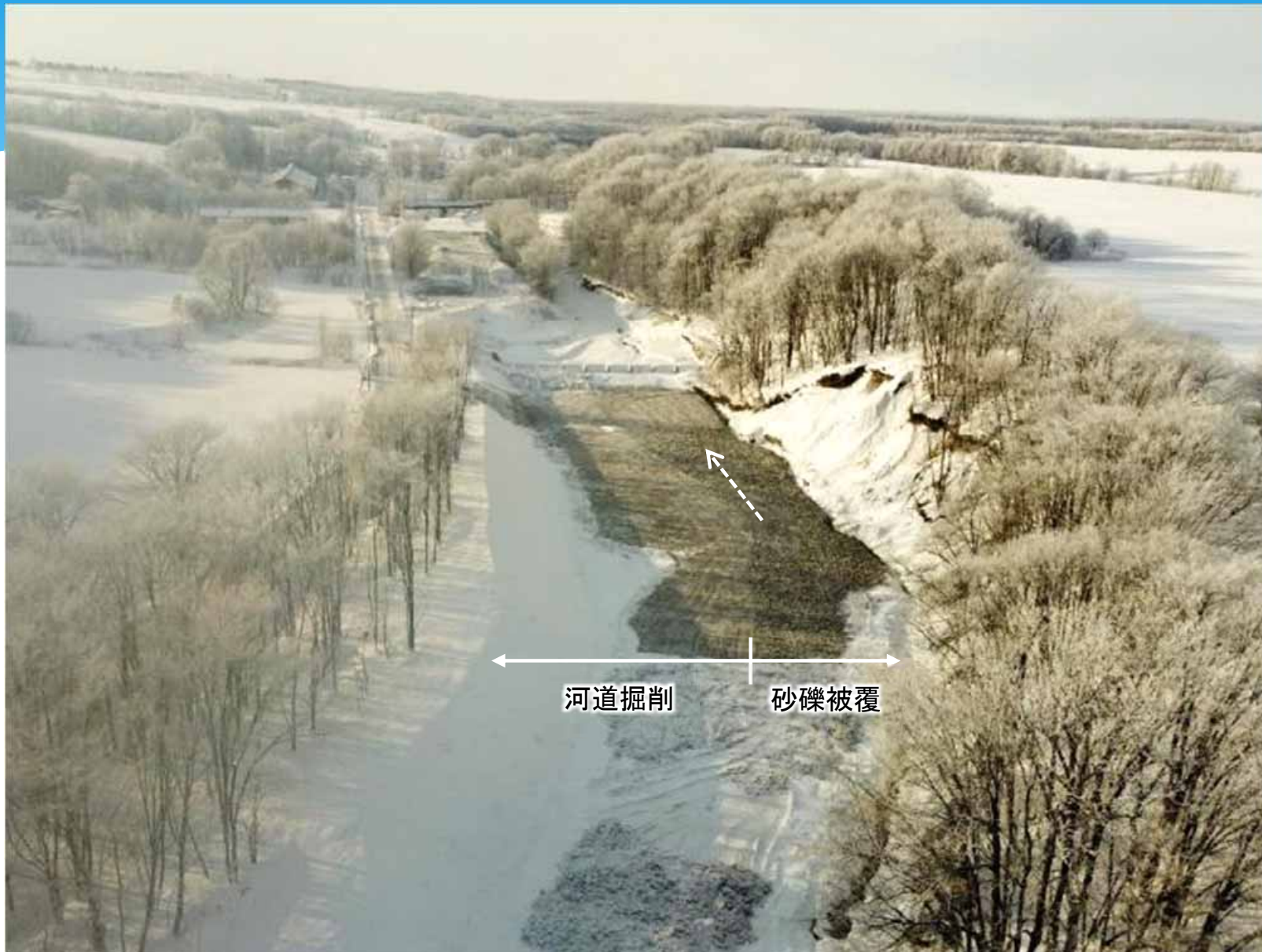
河道掘削と砂礫被覆 完了後の状況(R4.12.27)
