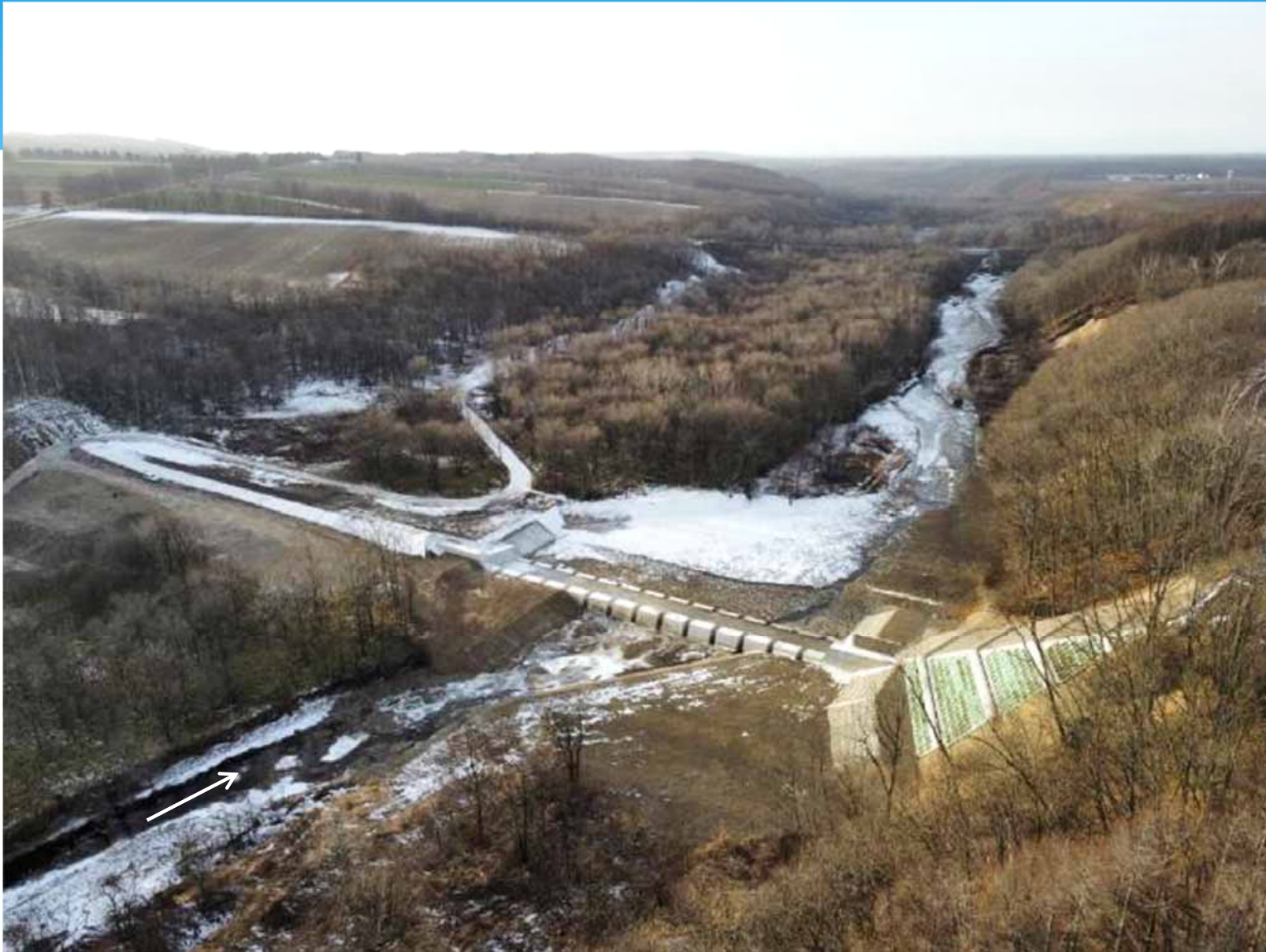
9号床固工 完成後の状況(R4.12.21)
