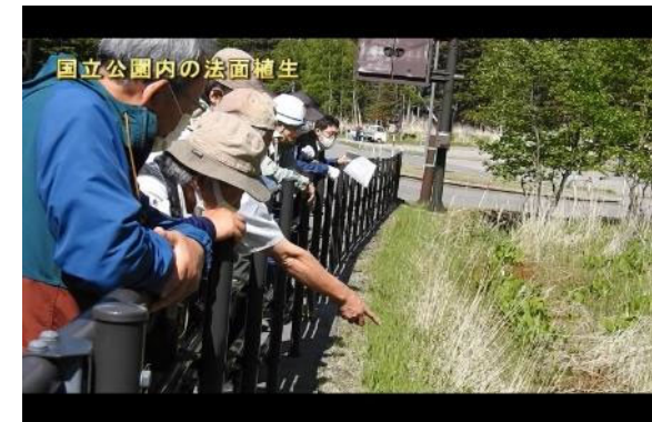
盛土部 確認状況
