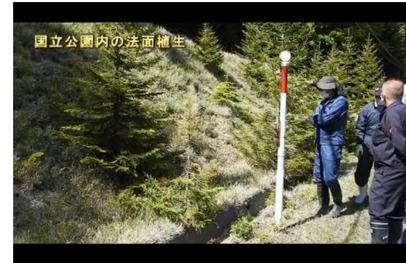
切土部 確認状況
