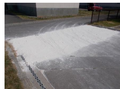
写真1： 1 \text{ kg/m}^2 の石灰ベルト
