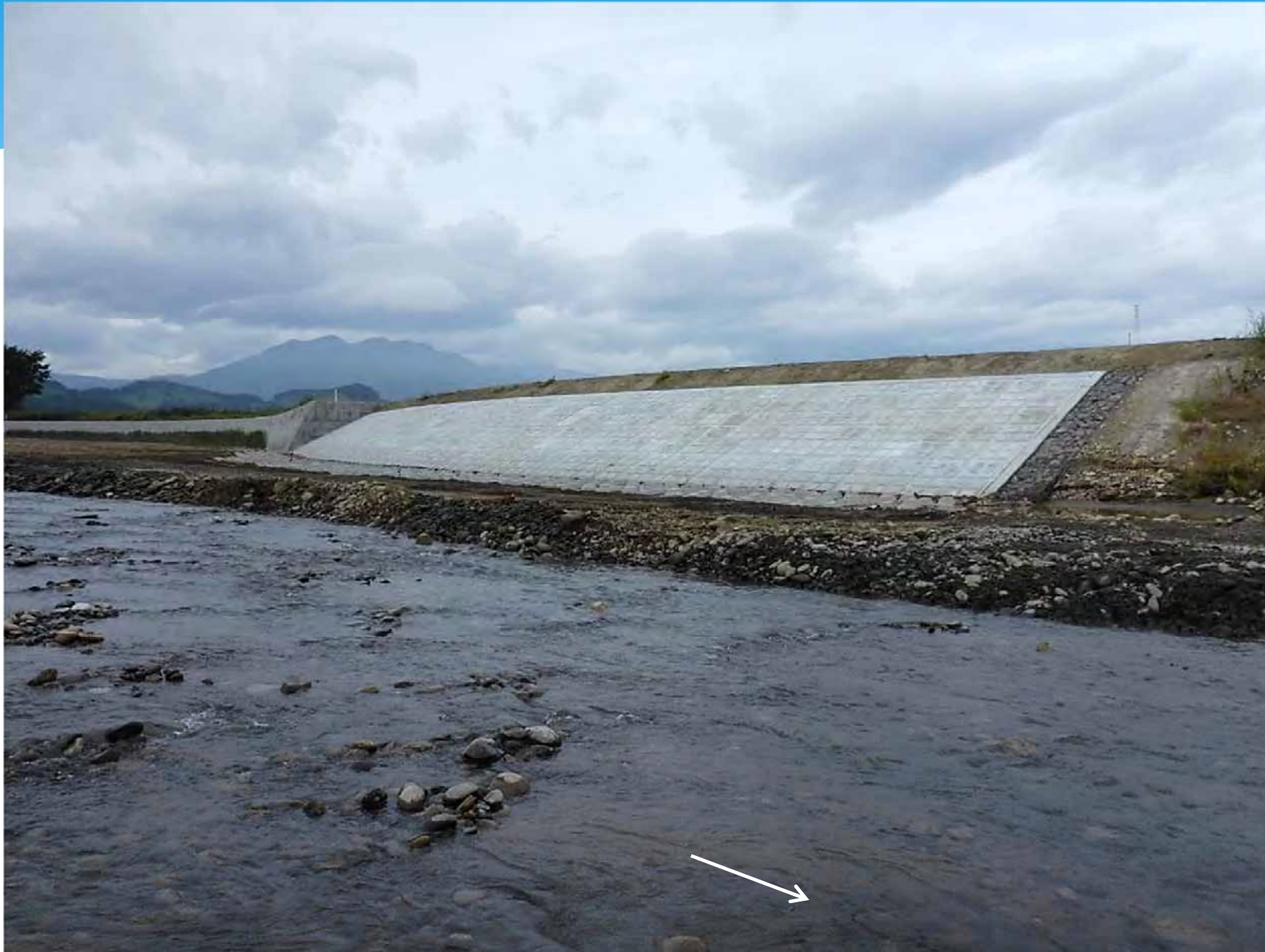
美生川改修工事 施工箇所状況(R4.9.13 完了後)
