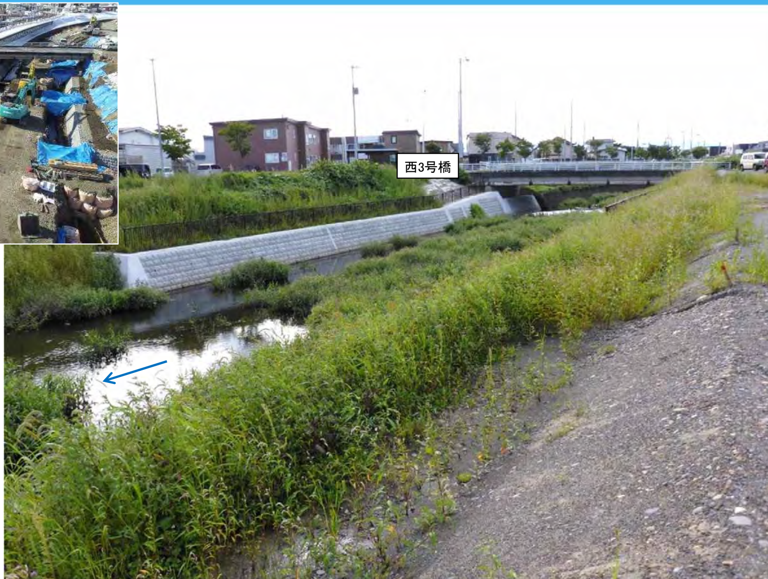
西3号橋下流 R3年度施工完了後 (R4.9.2)
