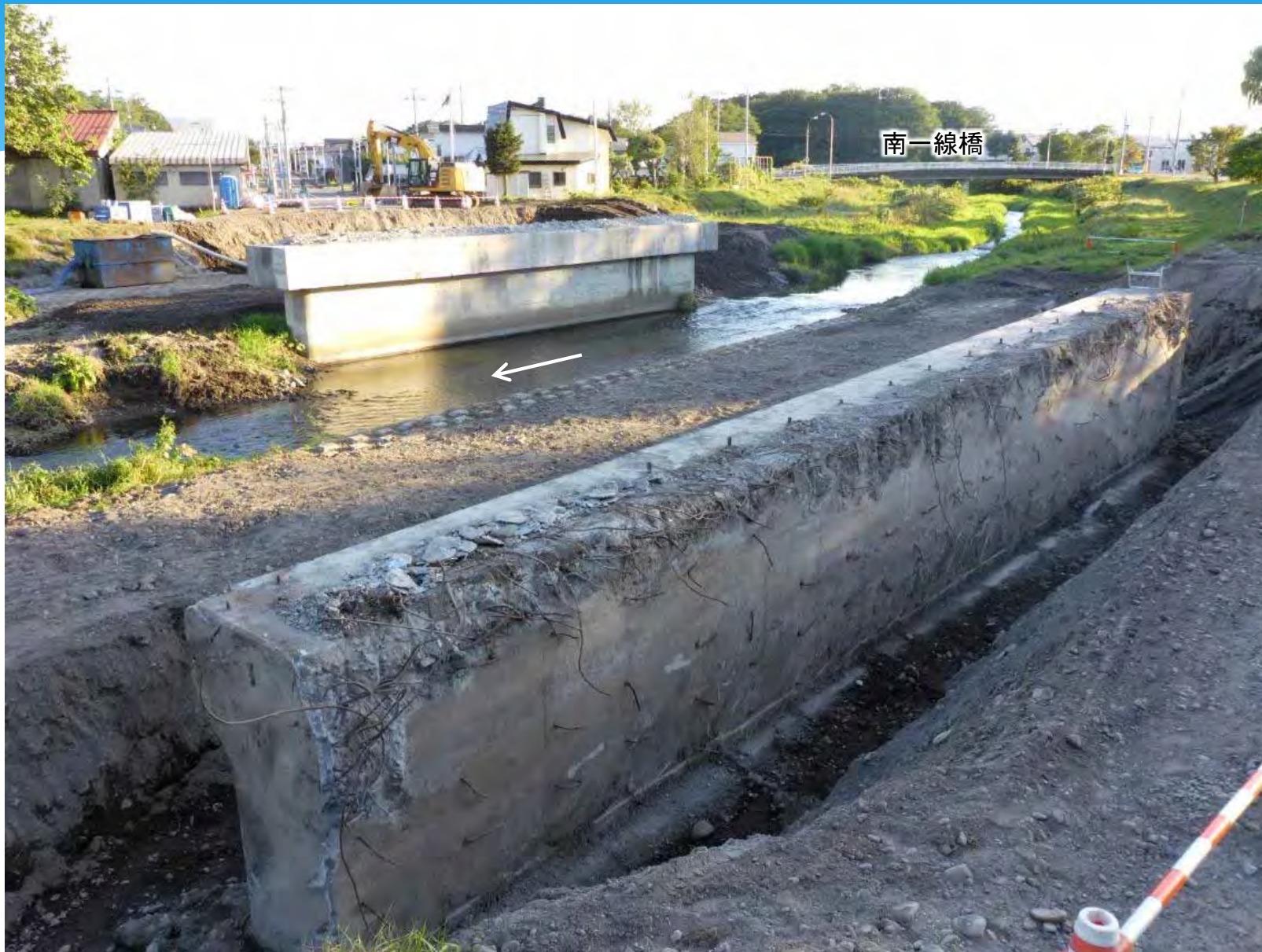
ピウカ橋解体状況と改修工事施工予定箇所状況 (R4.9.9)
