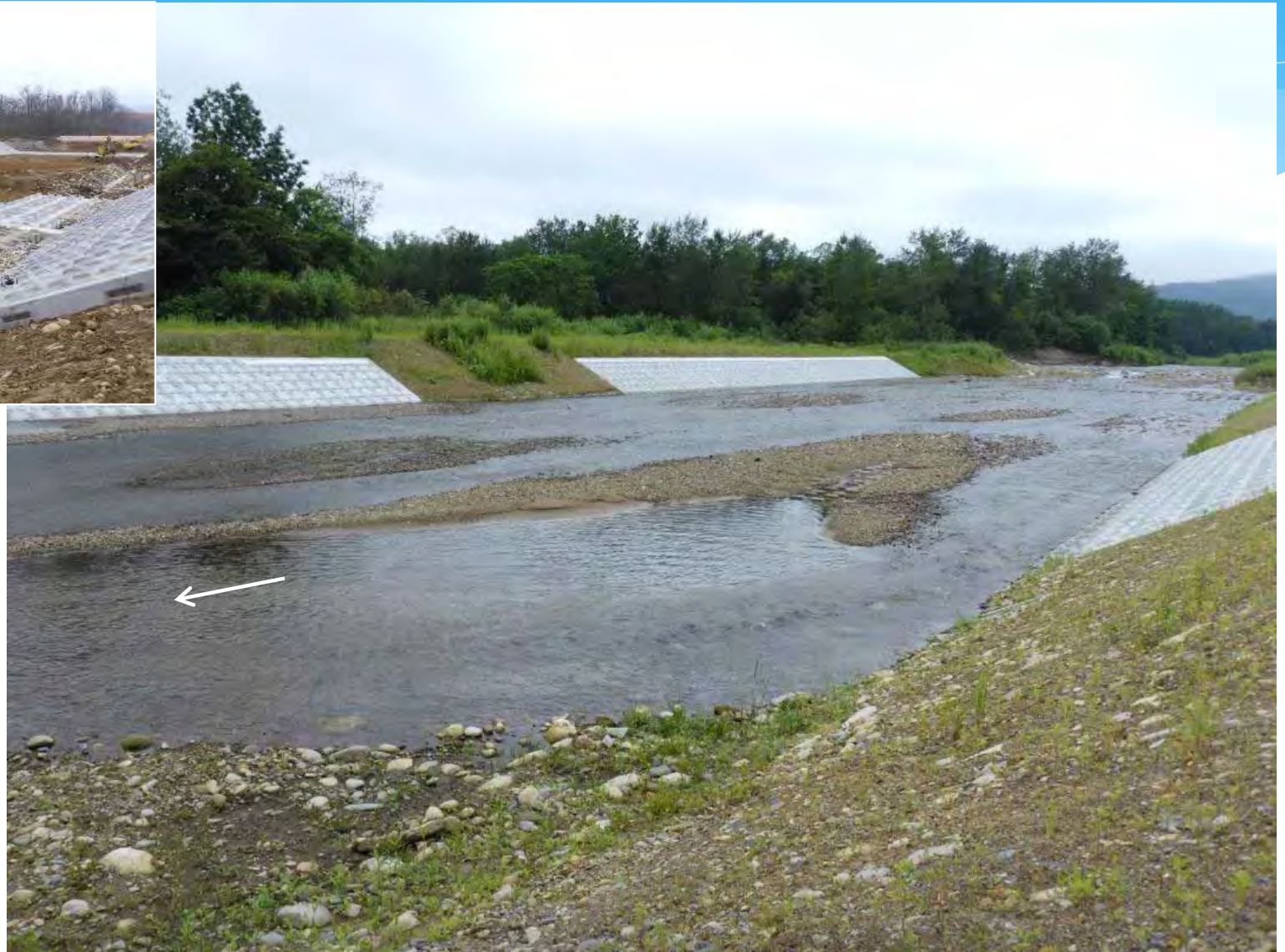
上美生橋上流 R3年度施工完了後状況 (R4.7.21)
