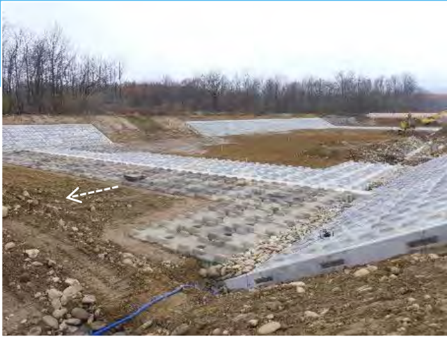
R3年度施工状況 (R3.11.8)
