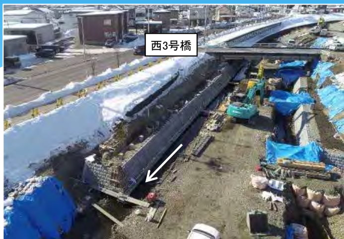
R3年度施工状況 (R4.2.10)
