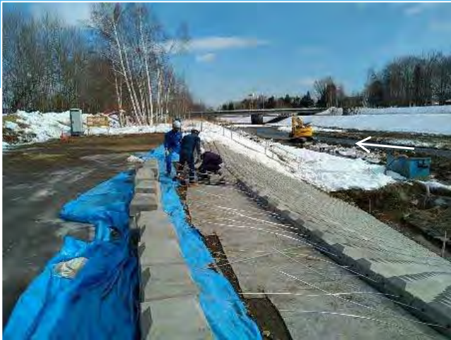
R3年度施工状況（R4.2.9）
