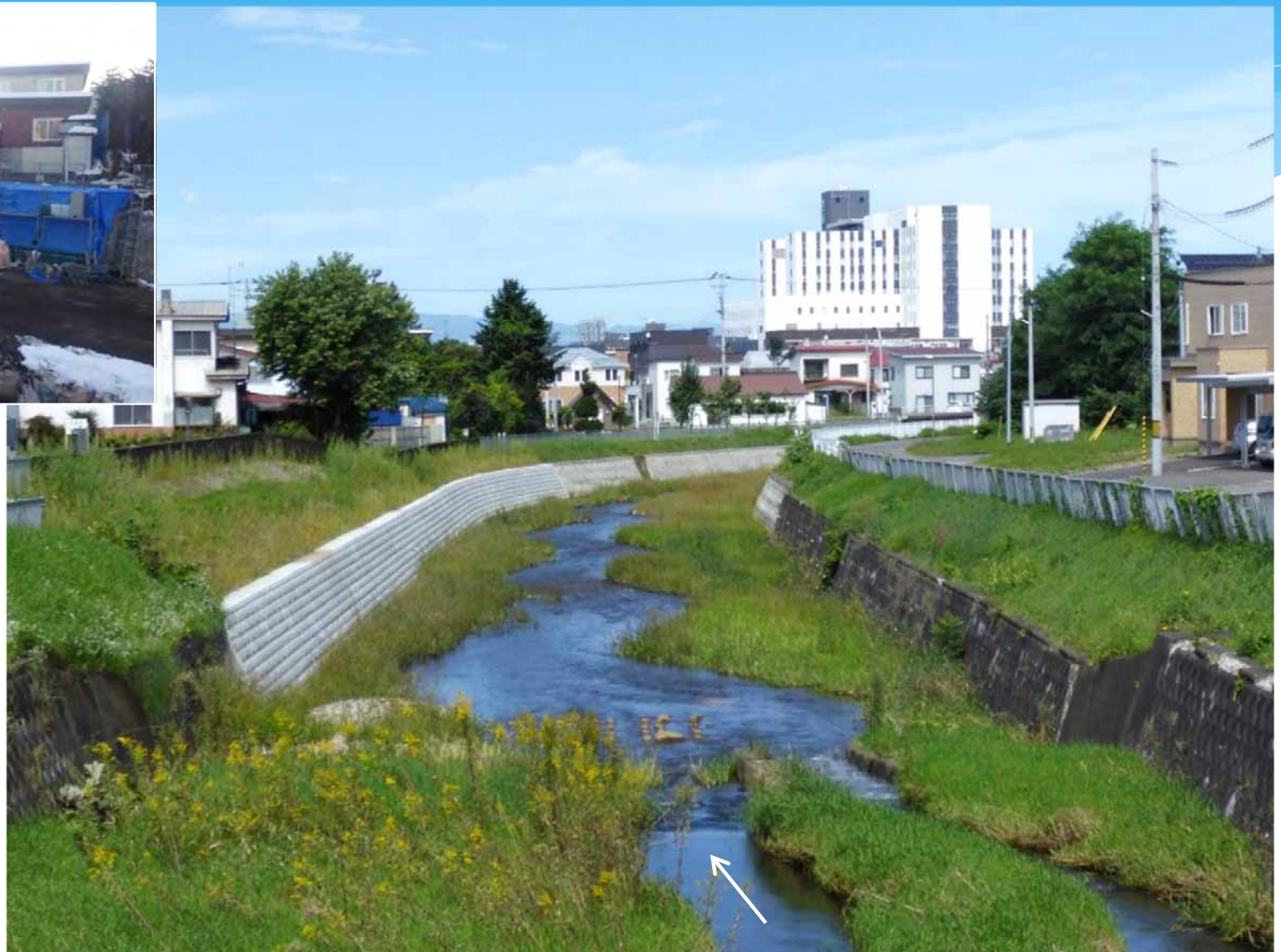
中駒橋下流 R3年度施工完了後 (R4.9.2)
