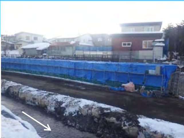
R3年度施工状況(R4.1.31)
