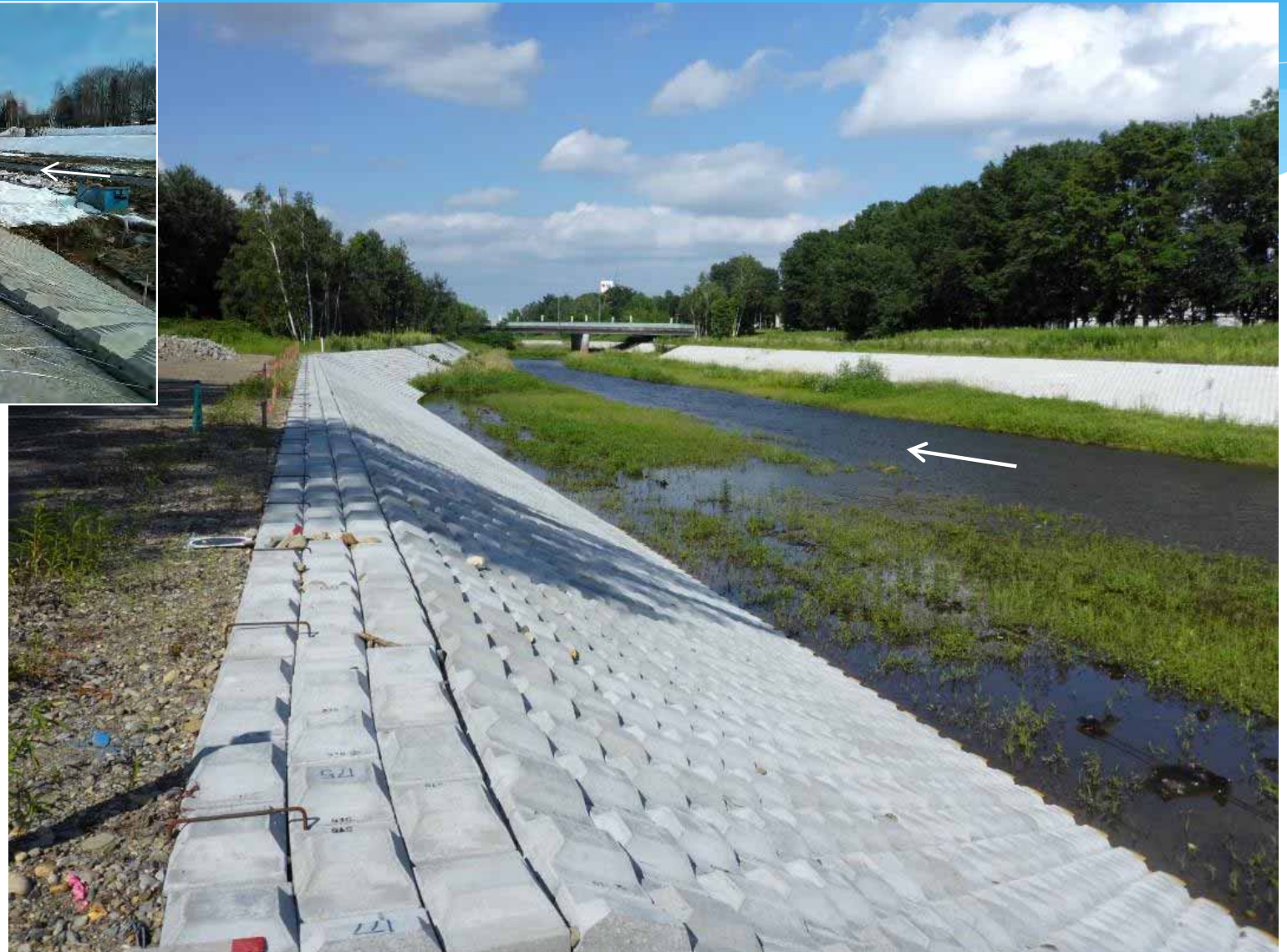
開西橋上流 R3年度施工完了後状況（R4.7.21）
