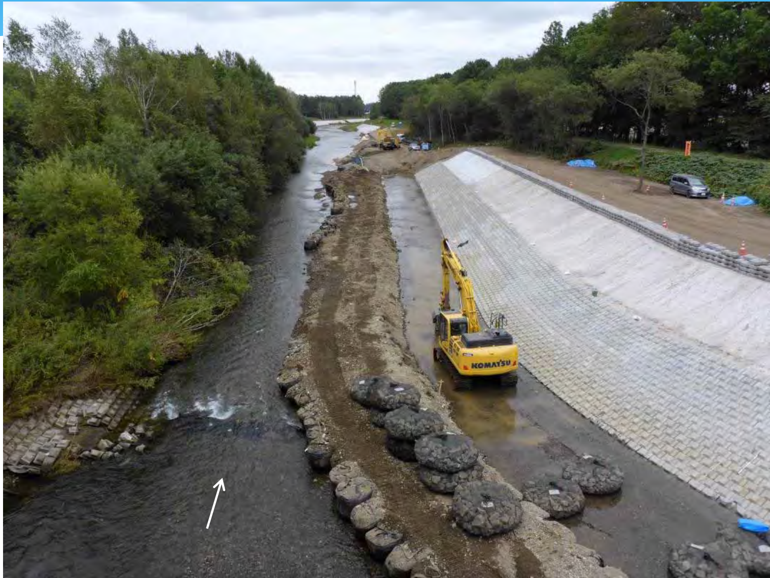
新川橋下流 施工箇所状況(R4.9.16)
