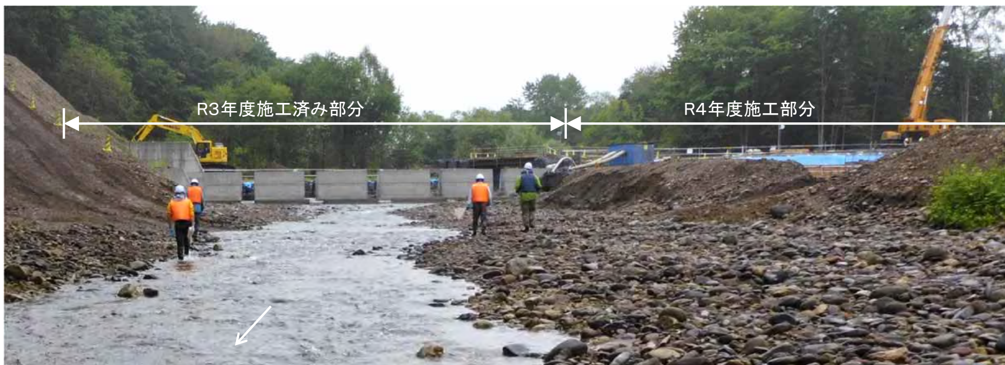
9号床固工滞筋状況(R4.8.23: 重要種魚類調査時)
