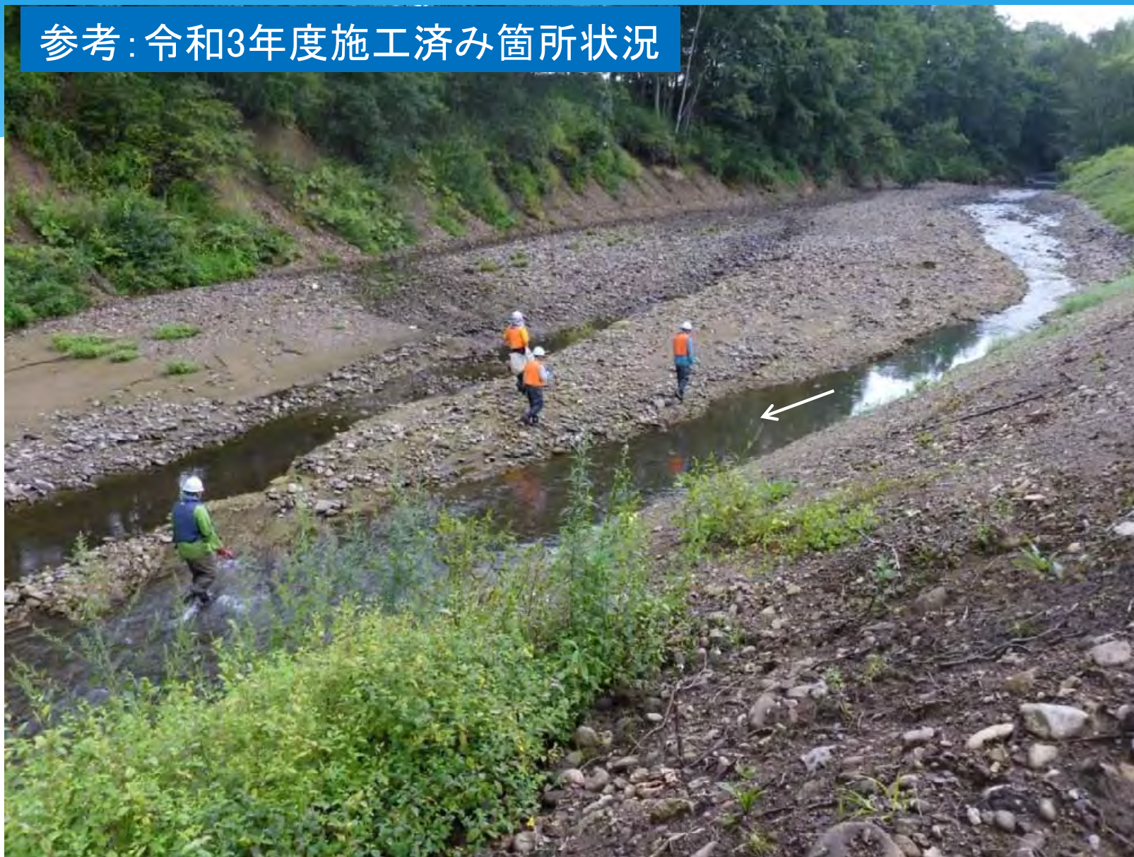
令和3年度 河道掘削と砂礫被覆の施工済み箇所状況(R4.8.23:重要種魚類調査時)
