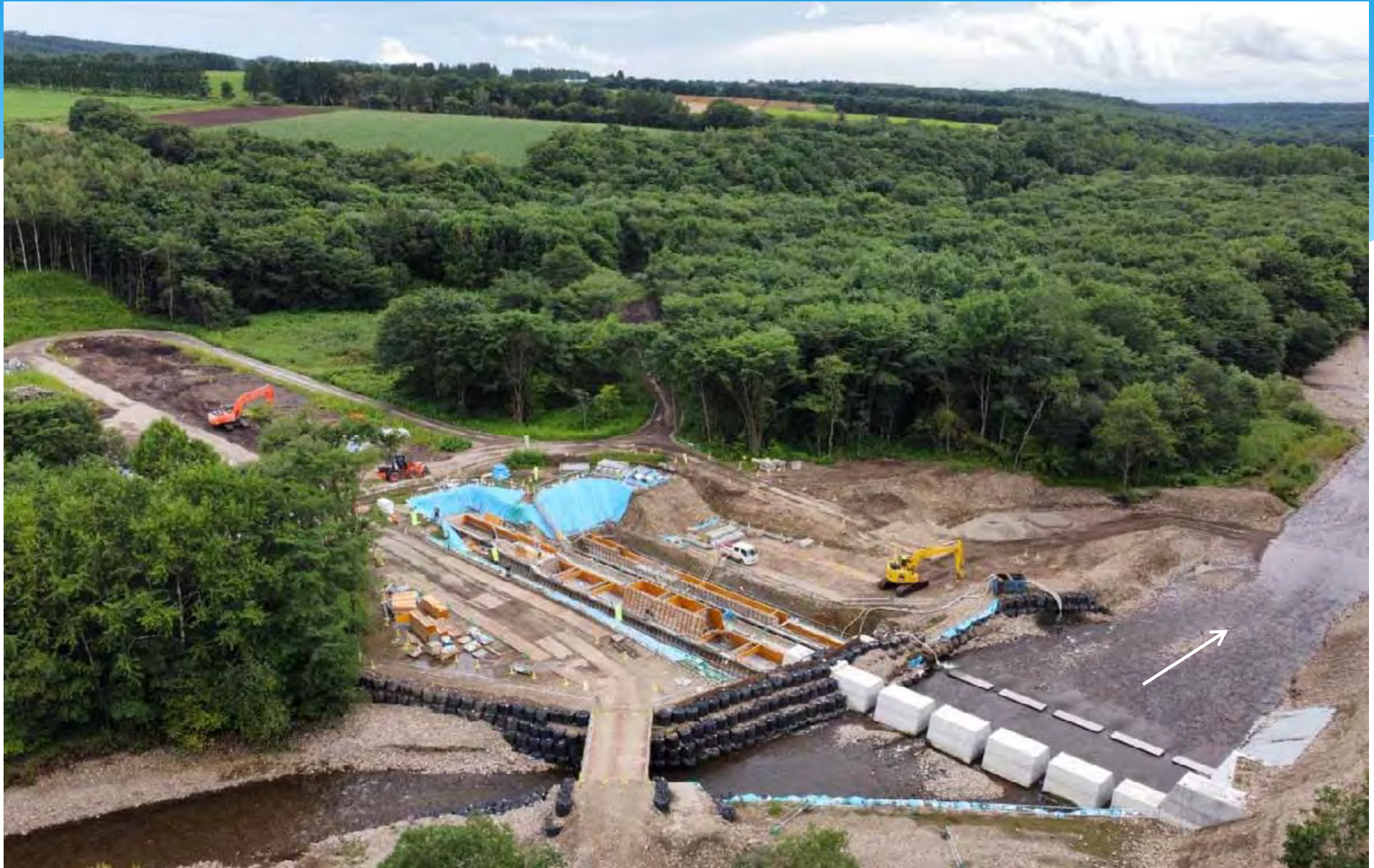
9号床固工 施工予定箇所状況(R4.8.11)
