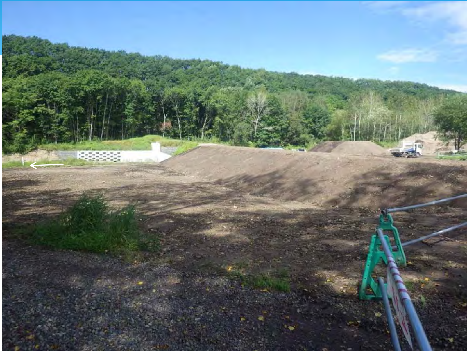
10号床固工 施工状況(R4.9.2)
