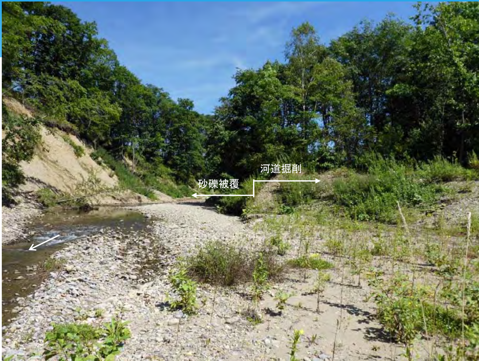
河道掘削と砂礫被覆 施工予定箇所状況(R4.8.22)
