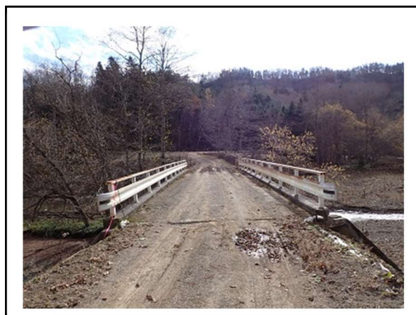
改良予定の橋梁
