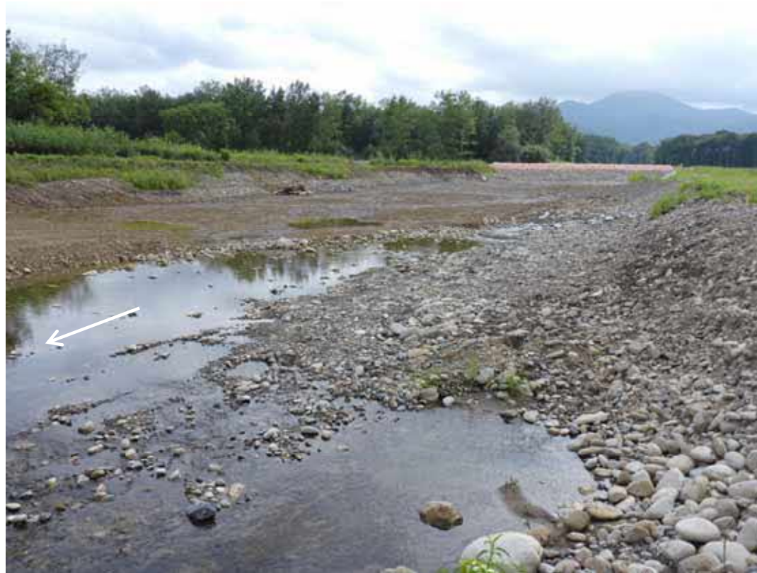
上美生橋上流 施工予定箇所状況(R3.8.12)
