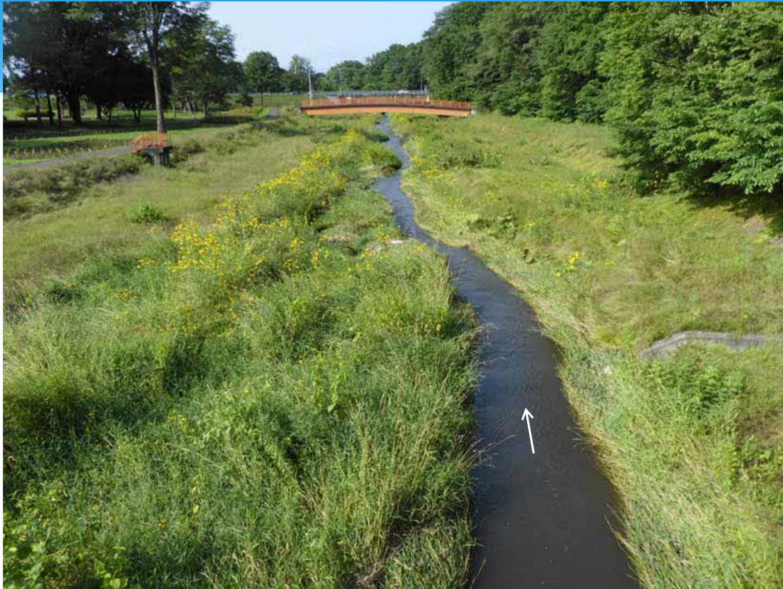
八丁目橋下流 施工予定箇所状況(R3.8.11)
