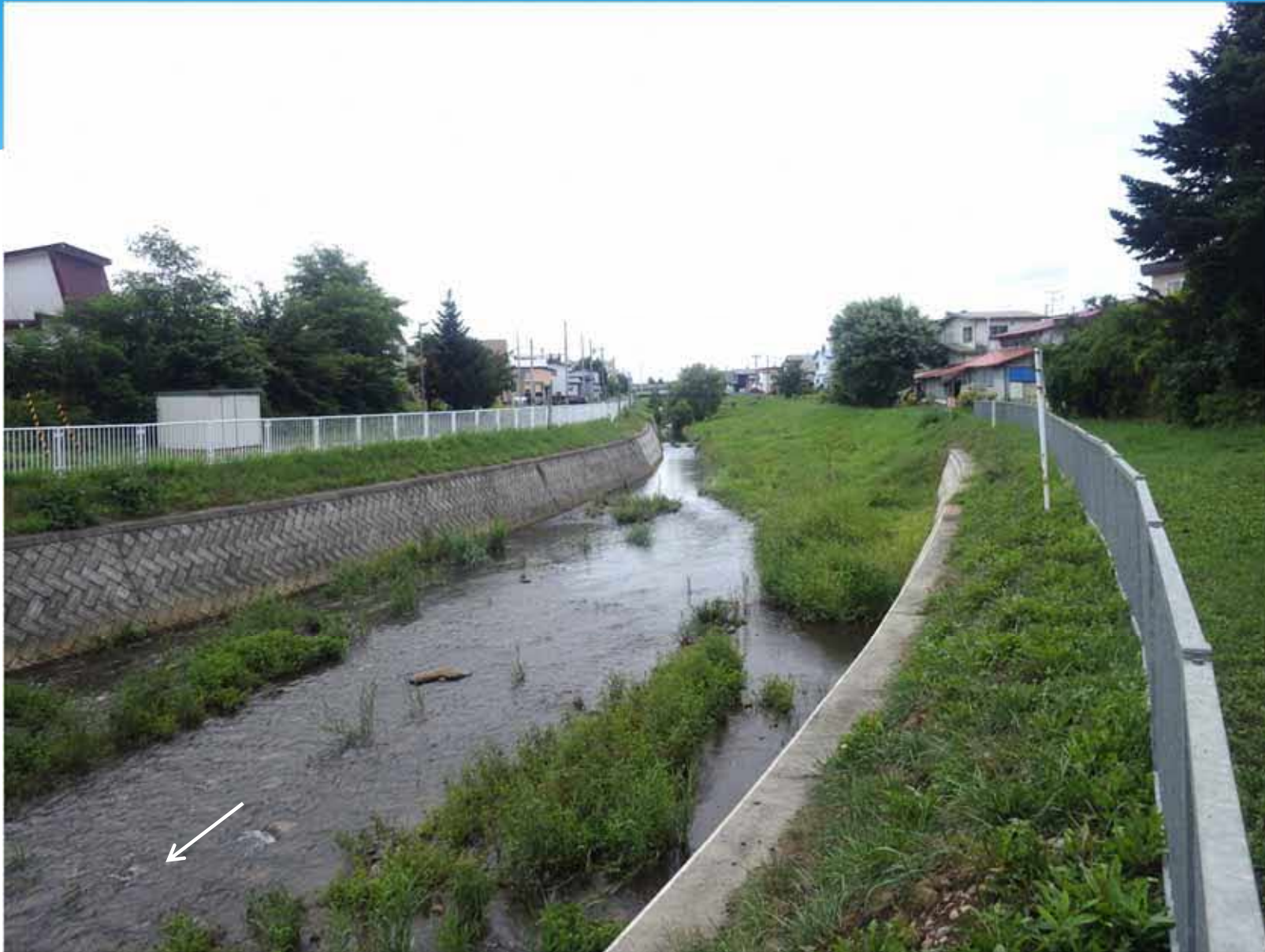
駒追橋上流：施工予定箇所状況（R3.8.12）
