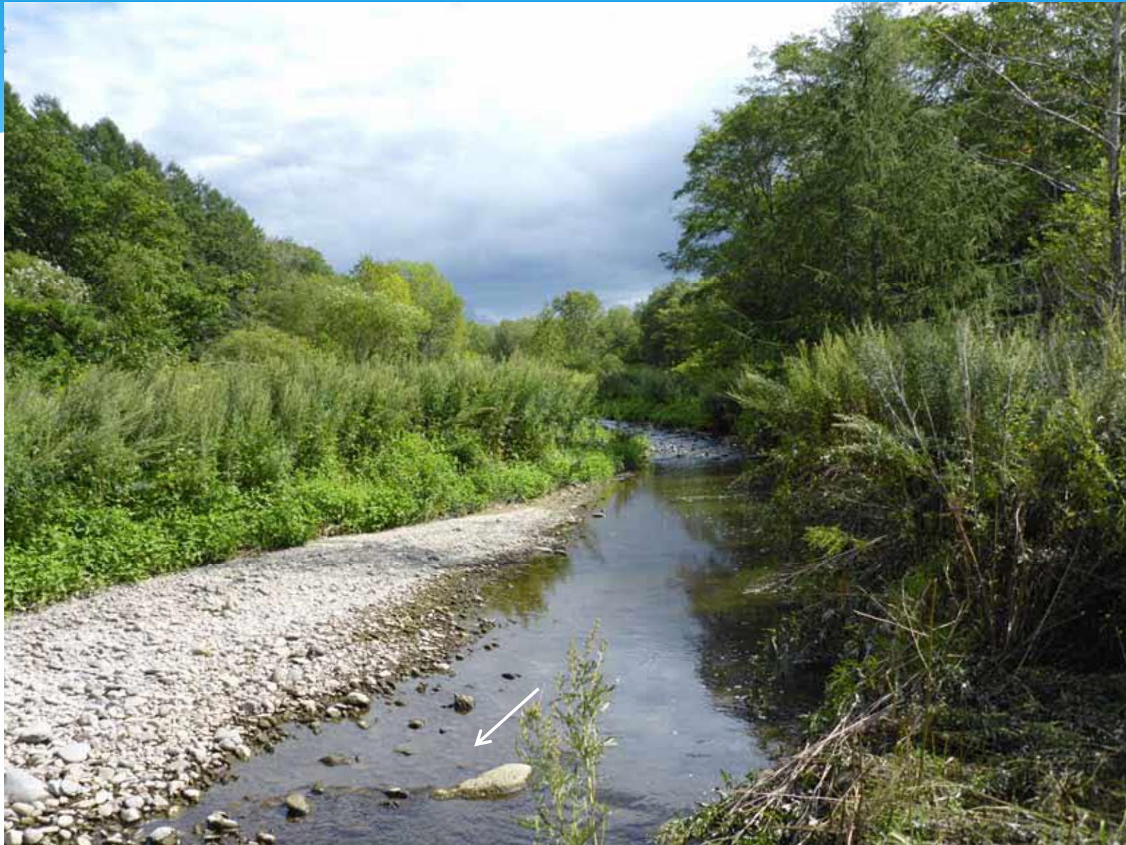
9号床固工 施工予定箇所状況(R3.9.2)
