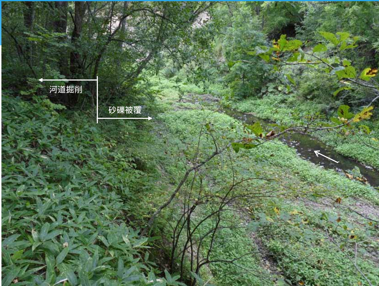
河道掘削と砂礫被覆 施工予定箇所状況(R3.9.2)
