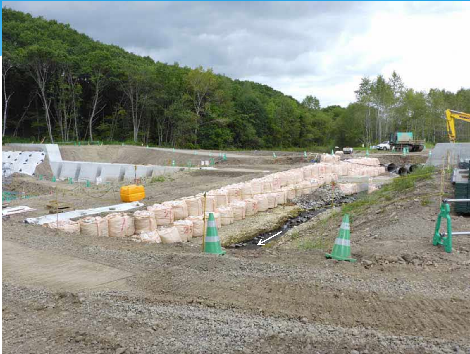
10号床固工 施工状況(R3.9.2)
