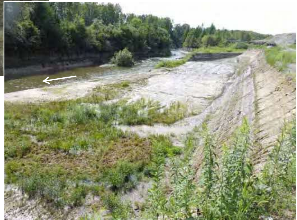
上流側 施工予定箇所状況(R3.8.11)
