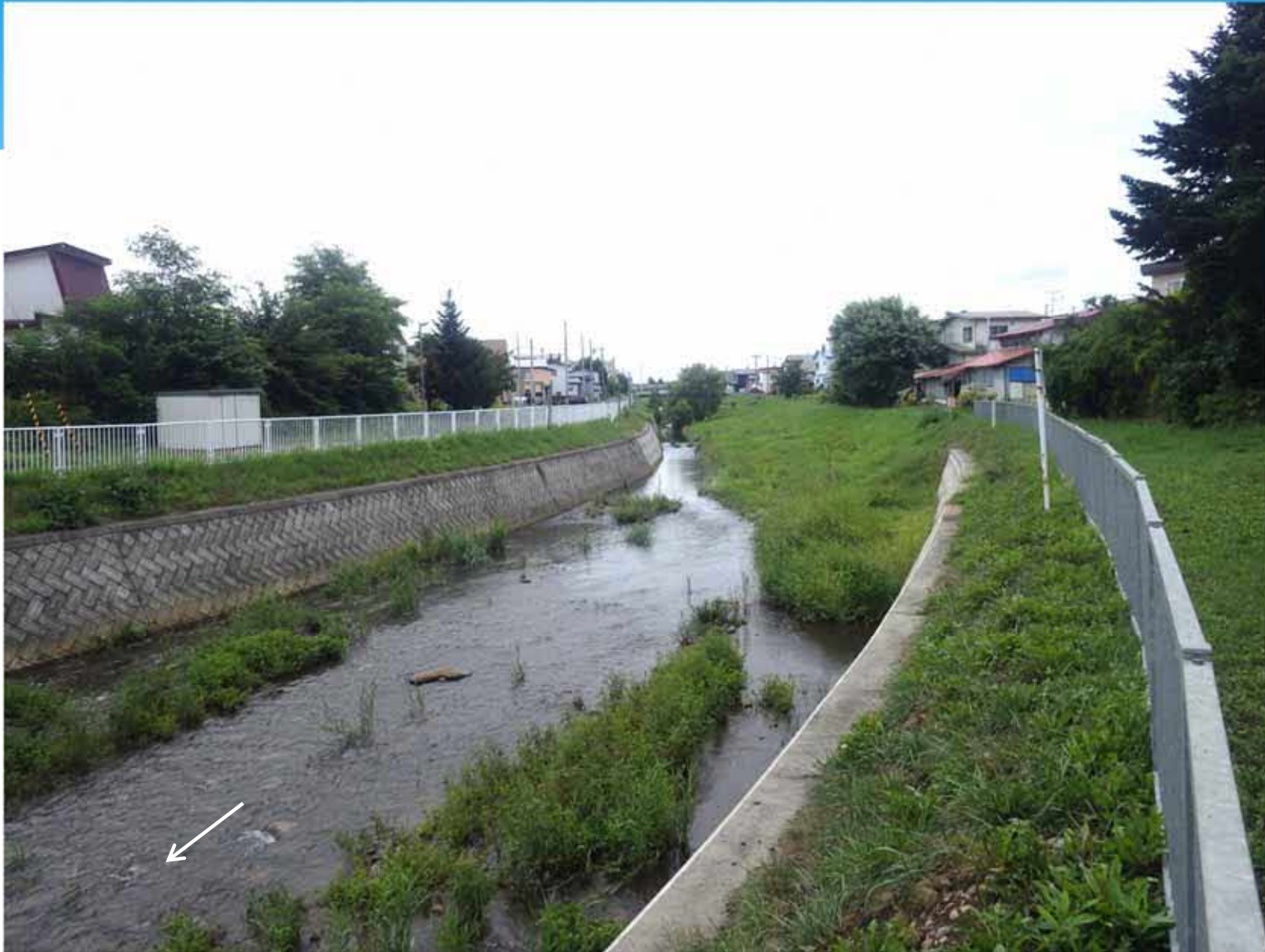
駒追橋上流:施工予定箇所状況(R3.8.12)
