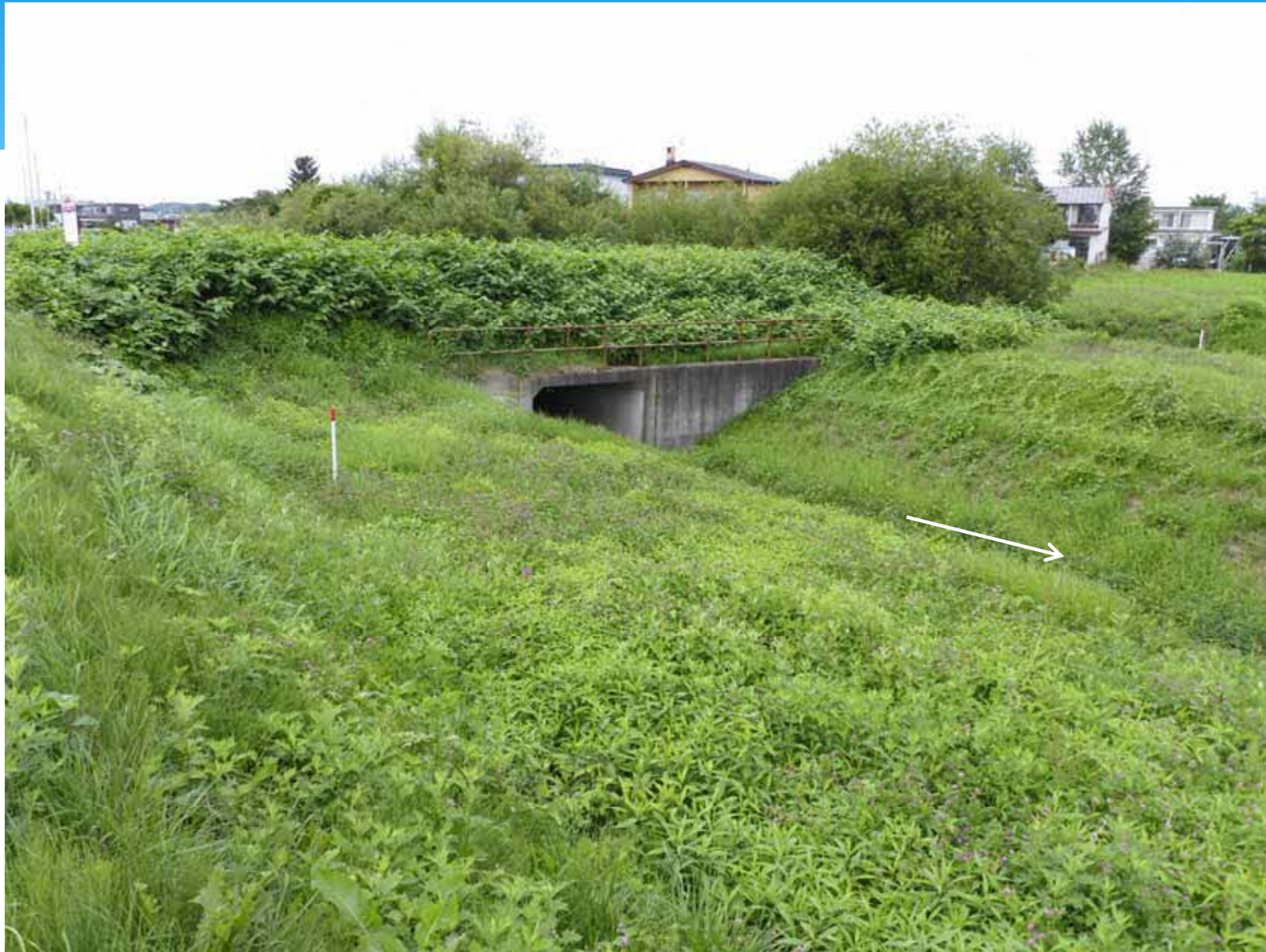
北親橋下流(旧士幌線箇所) 施工予定箇所状況(R3.8.12)
