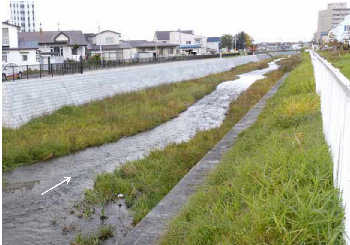
駒追橋下流：施工済み箇所の水路状況 (R3.10.22)
