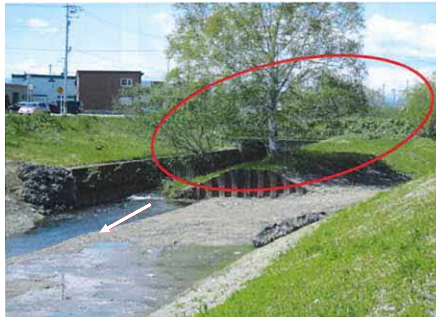
伐採する支障木
