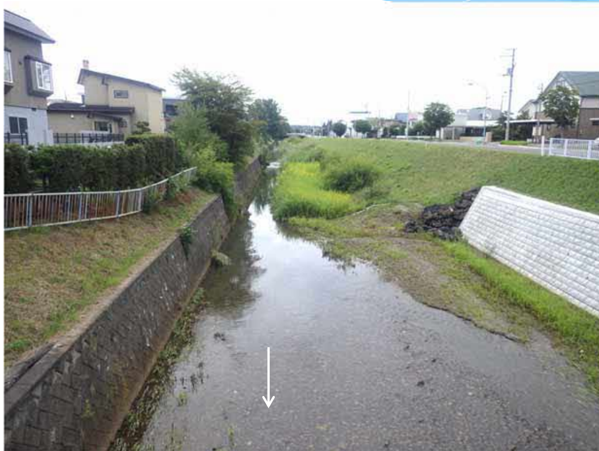
柏西第2号橋上流 施工予定箇所状況 (R3.8.12)
