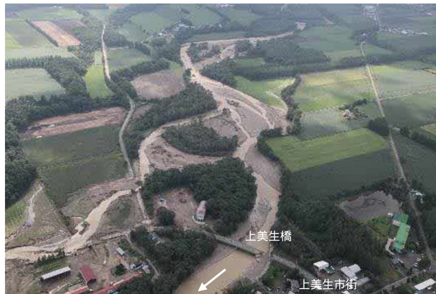
H28年災害時の上美生橋付近
