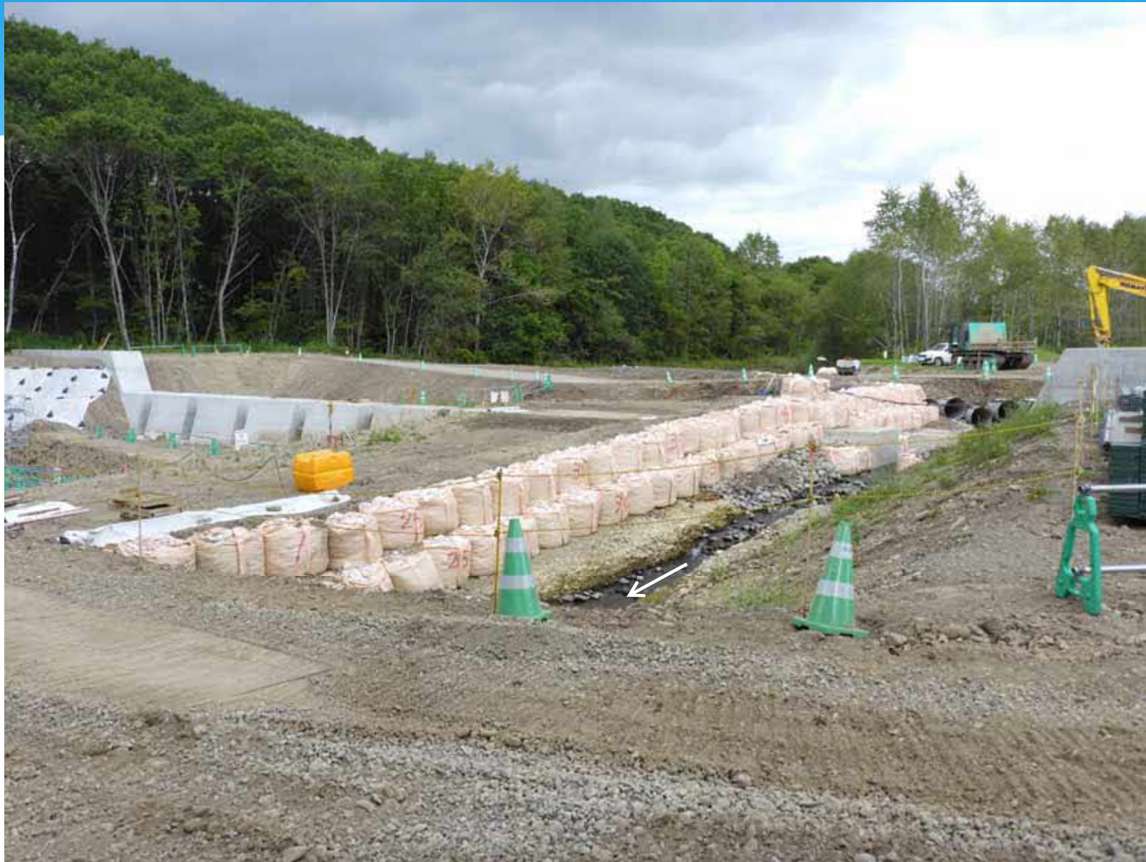
10号床固工 施工状況(R3.9.2)
