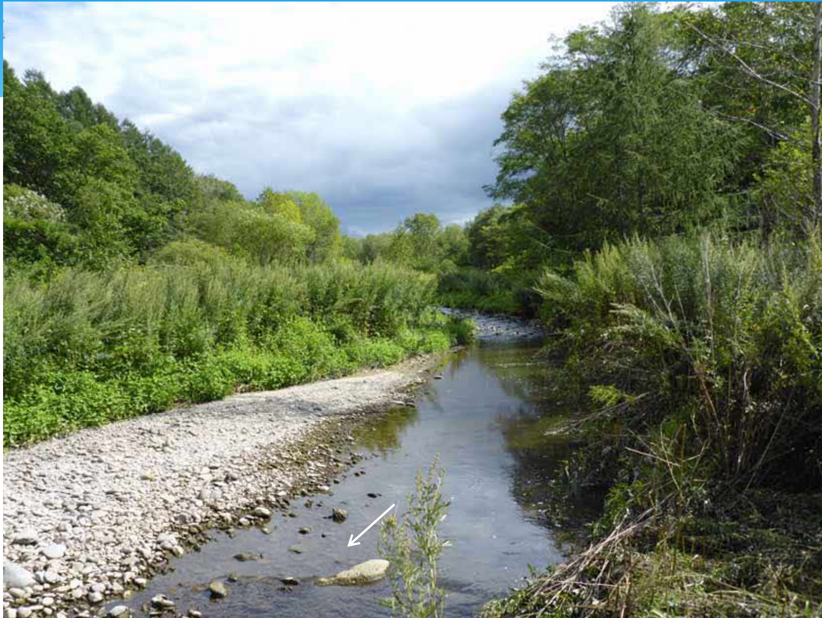
9号床固工 施工予定箇所状況(R3.9.2)
