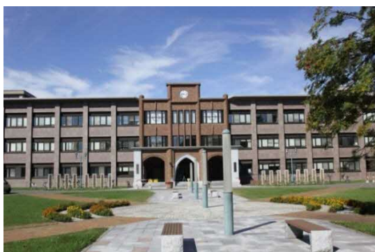
総合研究棟 I 号館
