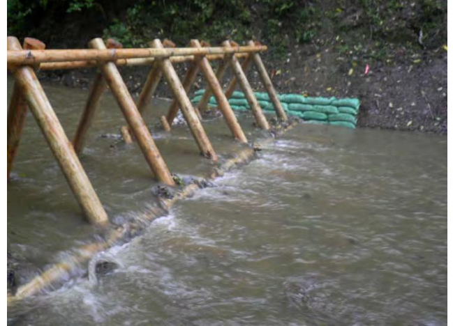
木製流木除け工（越流状況）
