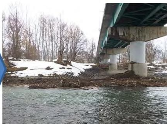
橋脚に堆積した流木と撤去後の状況
