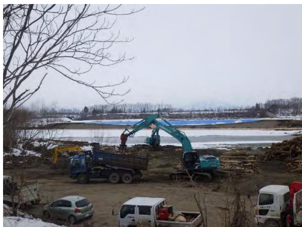
流木の撤去の状況（戸蔭別川）
