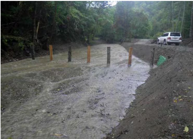
丸太差込式流木捕捉工（上流から下流方向）
