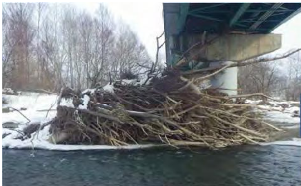
橋脚に堆積した流木と撤去後の状況
