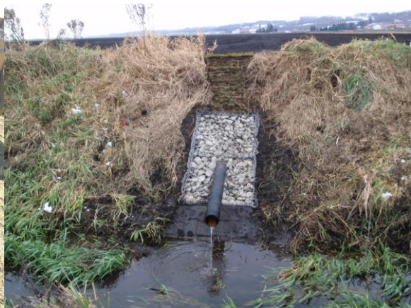
写真.暗渠設置後の排水状況
