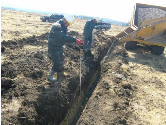
写真.暗渠排水工事
