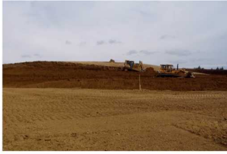
工事中の状況
