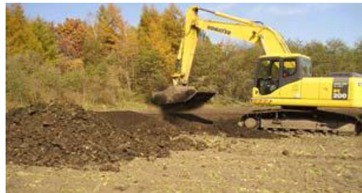
（作土を網状のバケットで振るっている状況）
