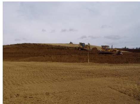
（勾配修正の状況）
