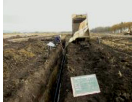
（吸水管を設置後、埋め戻し砂利の投入状況）
