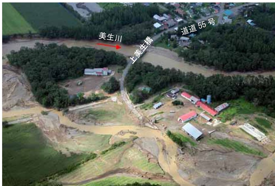
▲上美生橋付近の被災状況 <平成 28 年 8 月>
