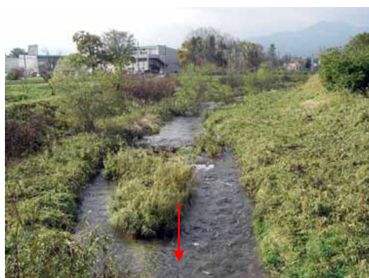
▲神社橋人道橋より上流（下流部）
