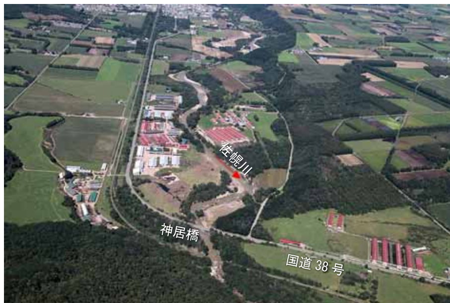
▲ 神居橋付近の被災状況 <平成 28 年 8 月>
