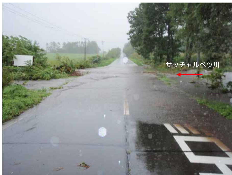
▲村道東 5 号線の道路冠水状況 ＜平成 23 年 9 月＞
