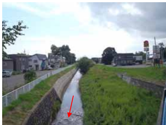
▲ 蹄橋より上流（下流部）
