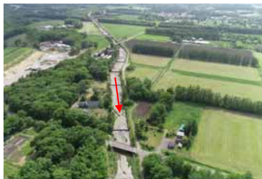
▲4号橋付近上空より上流(中流部)
