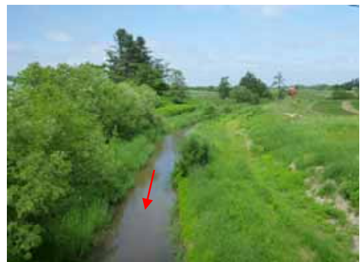
▲相川20号橋より上流（中流部）
