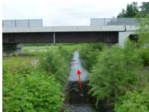
▲第 11 号橋梁より下流（上流部）
