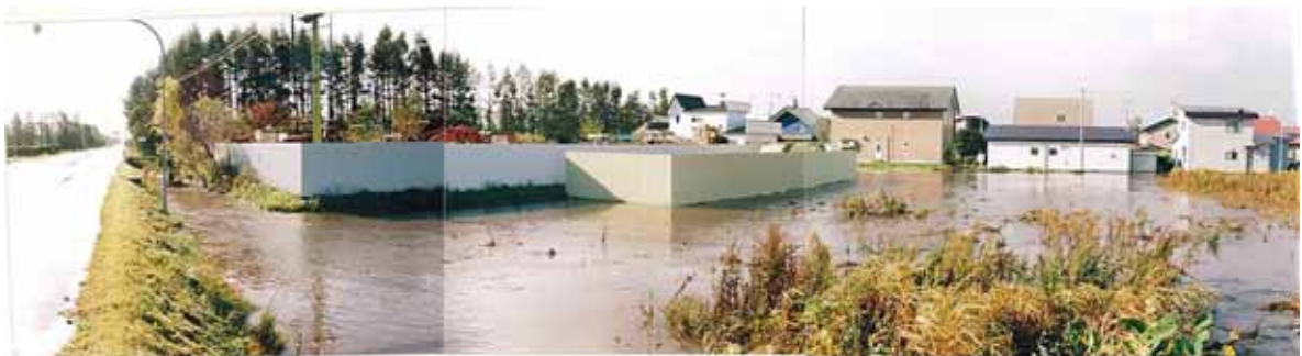
▲更新橋上流約 10m 地点 ＜平成 14 年 10 月＞
