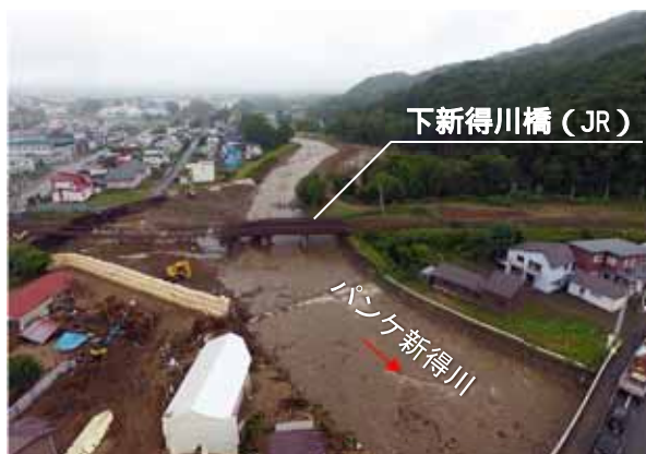
▲鉄道橋付近の被災状況
