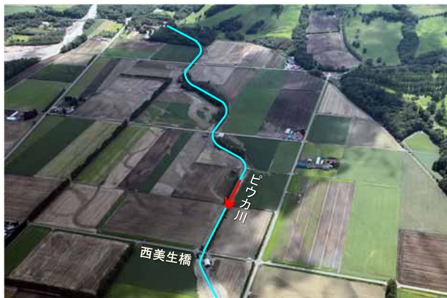
▲ 西美生橋付近の被災状況 < 平成 28 年 8 月 >
