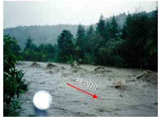
▲ 万代橋付近の増水状況 < 平成14年10月 >
