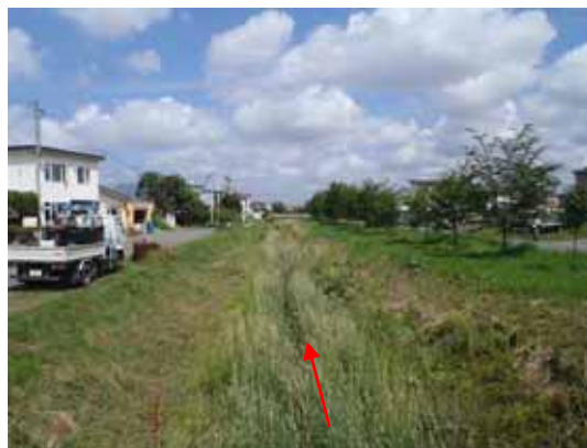
▲ 南 10 線橋より下流（上流部）
