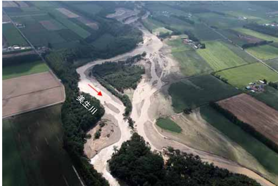
▲新嵐山橋上流付近の被災状況 <平成 28 年 8 月>
