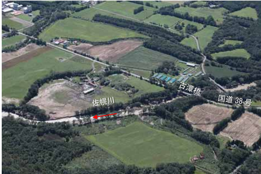
▲ 古潭橋付近の被災状況 <平成 28 年 8 月>
