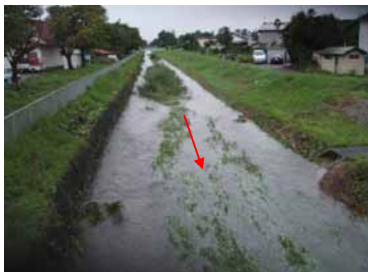
▲ 光西橋上流の河川水位上昇 < 平成23年9月 >
