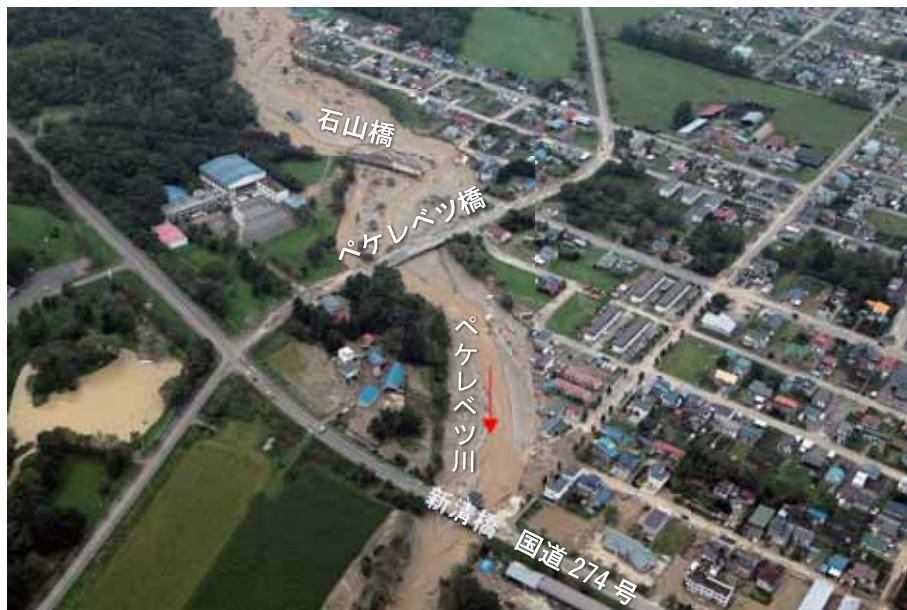
▲石山橋付近の被災状況 <平成 28 年 8 月>
