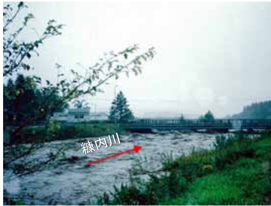
▲ 万代橋付近の増水状況 < 平成14年10月 >
