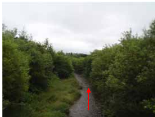
▲ 勢望橋より下流（下流部）
