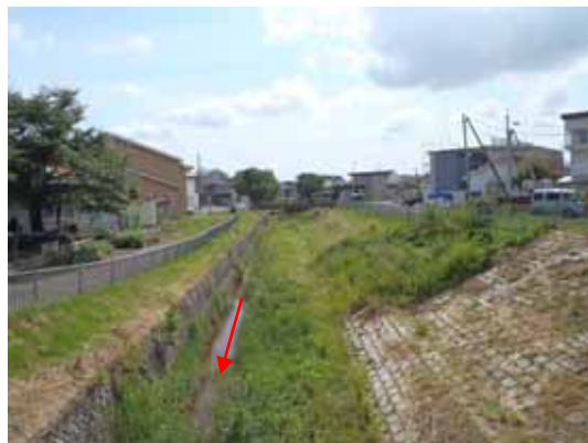
▲ 善隣橋より上流（中流部）
