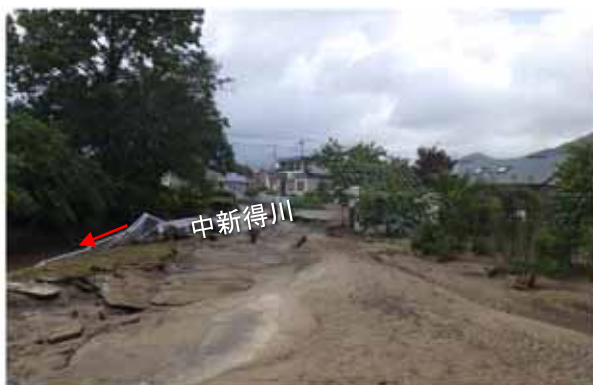
▲ 3 条橋付近の被災状況
