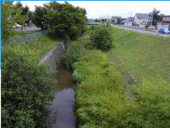
施工前の状況(R2.8.4)
