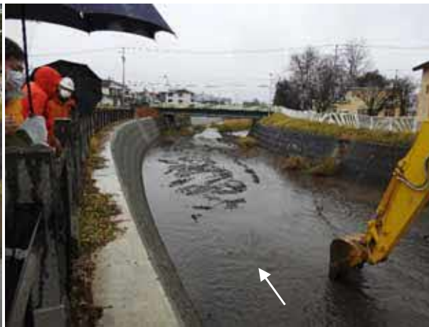
現場で確認しながらの整備作業
