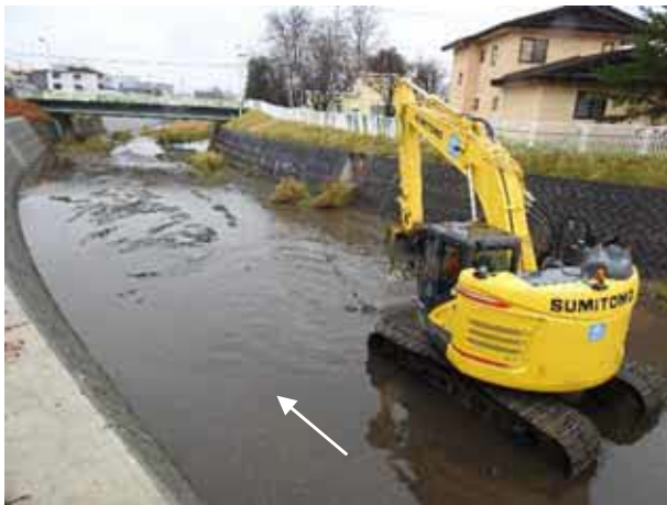
バックホウによる掘削
