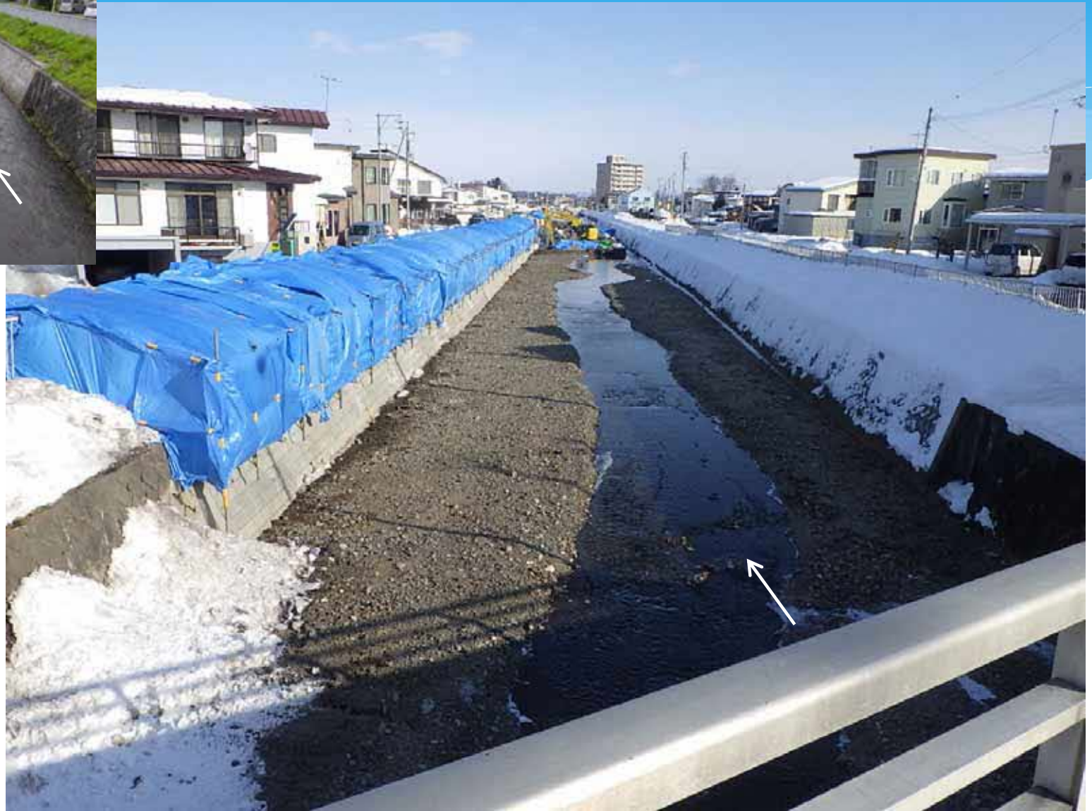
駒追橋下流: 施工状況(R3.2.5)
