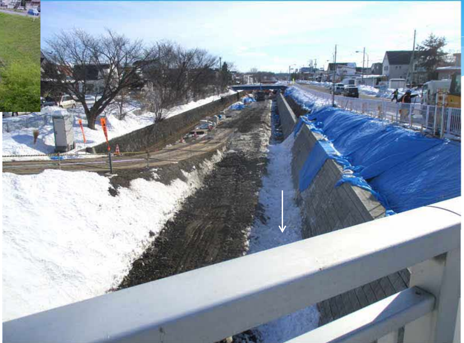
柏林台橋上流: 施工状況(R3.2.5)
