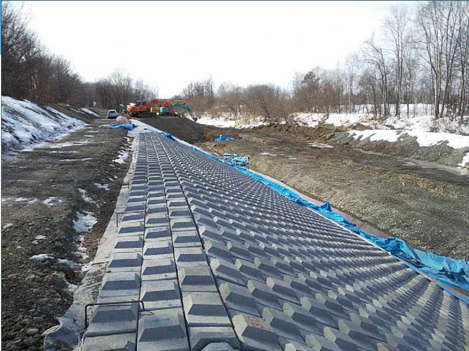
開西橋上流 施工状況(R3.217)
