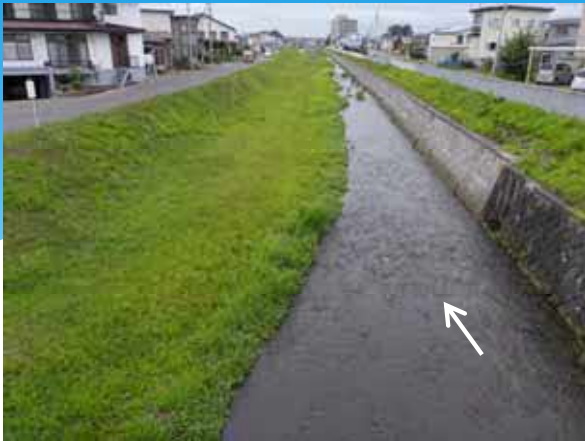
施工前の状況(R2.9.2)
