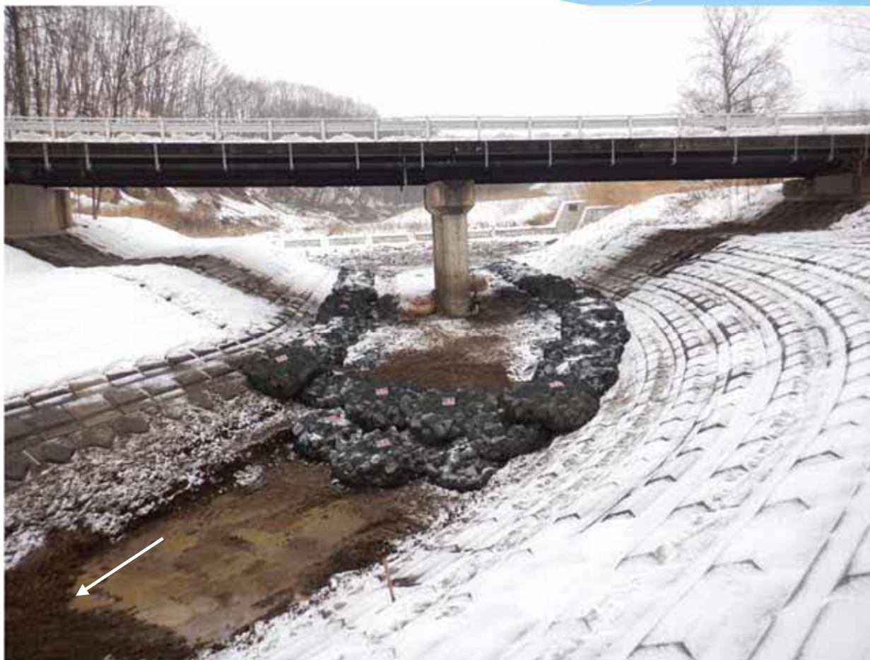
施工後の東大橋下流部 (R3.2.18)
