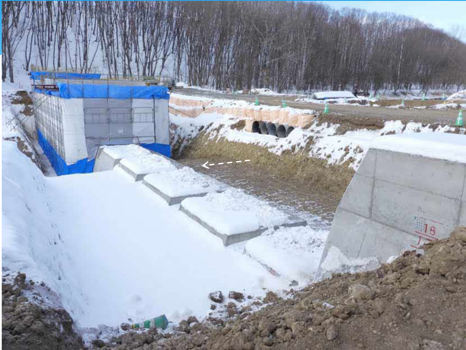
10号床固工 施工状況 (R3.2.5)
