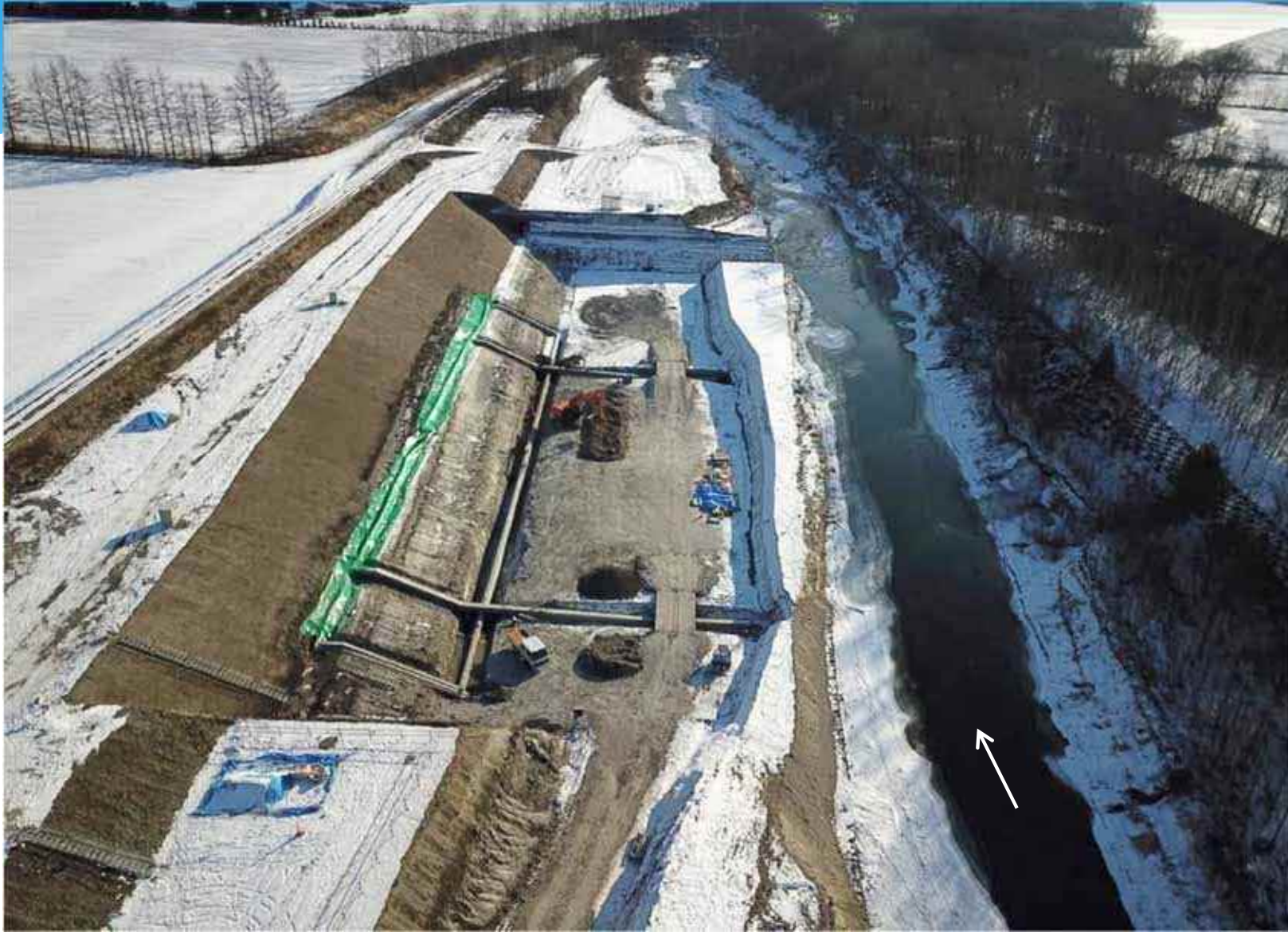
施工状況(R2.1.16)
