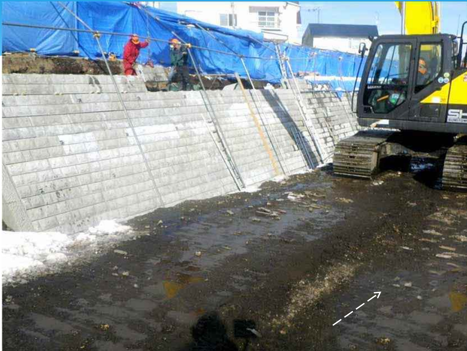
施工状況(R2.2.1)
