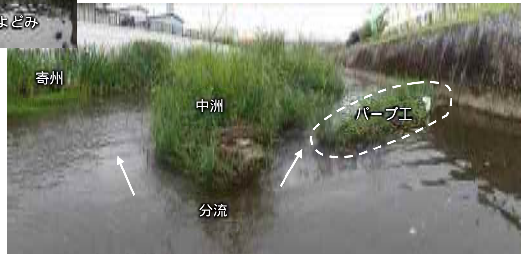
右岸下流から2基目のバーブ工 (平成29年設置)とその周辺
