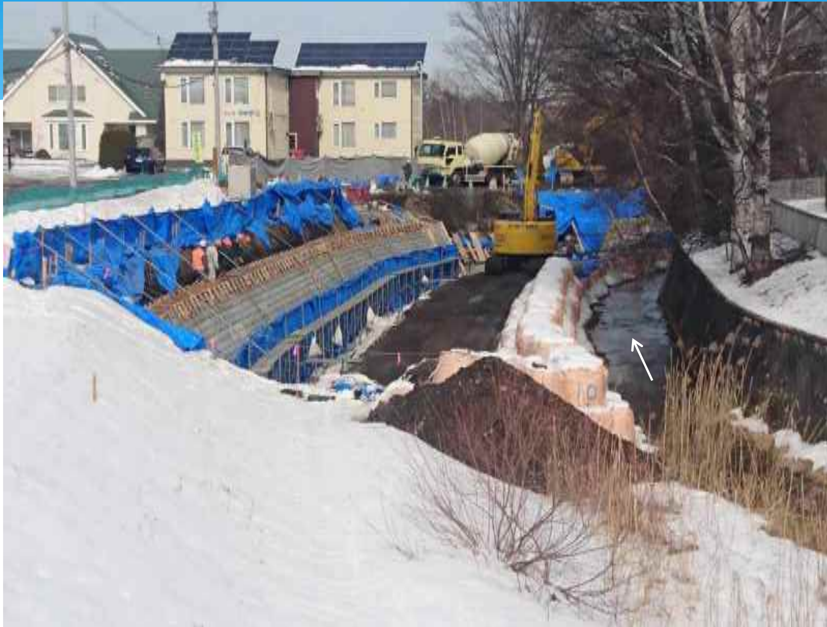
施工状況(R2.2.13)
