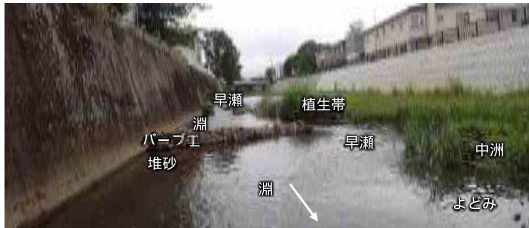
右岸最上流のバーブ工 (平成30年設置)とその周辺
