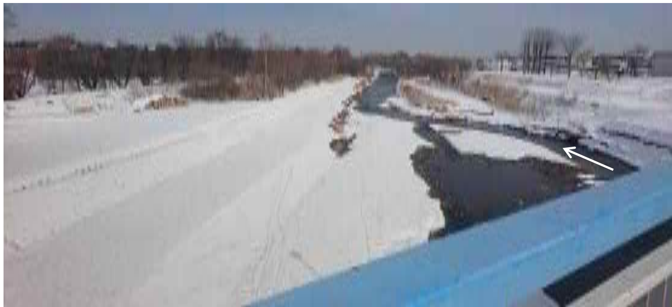
施工状況 上:開西橋より下流、下:伏古橋より下流(R2.2.13)
