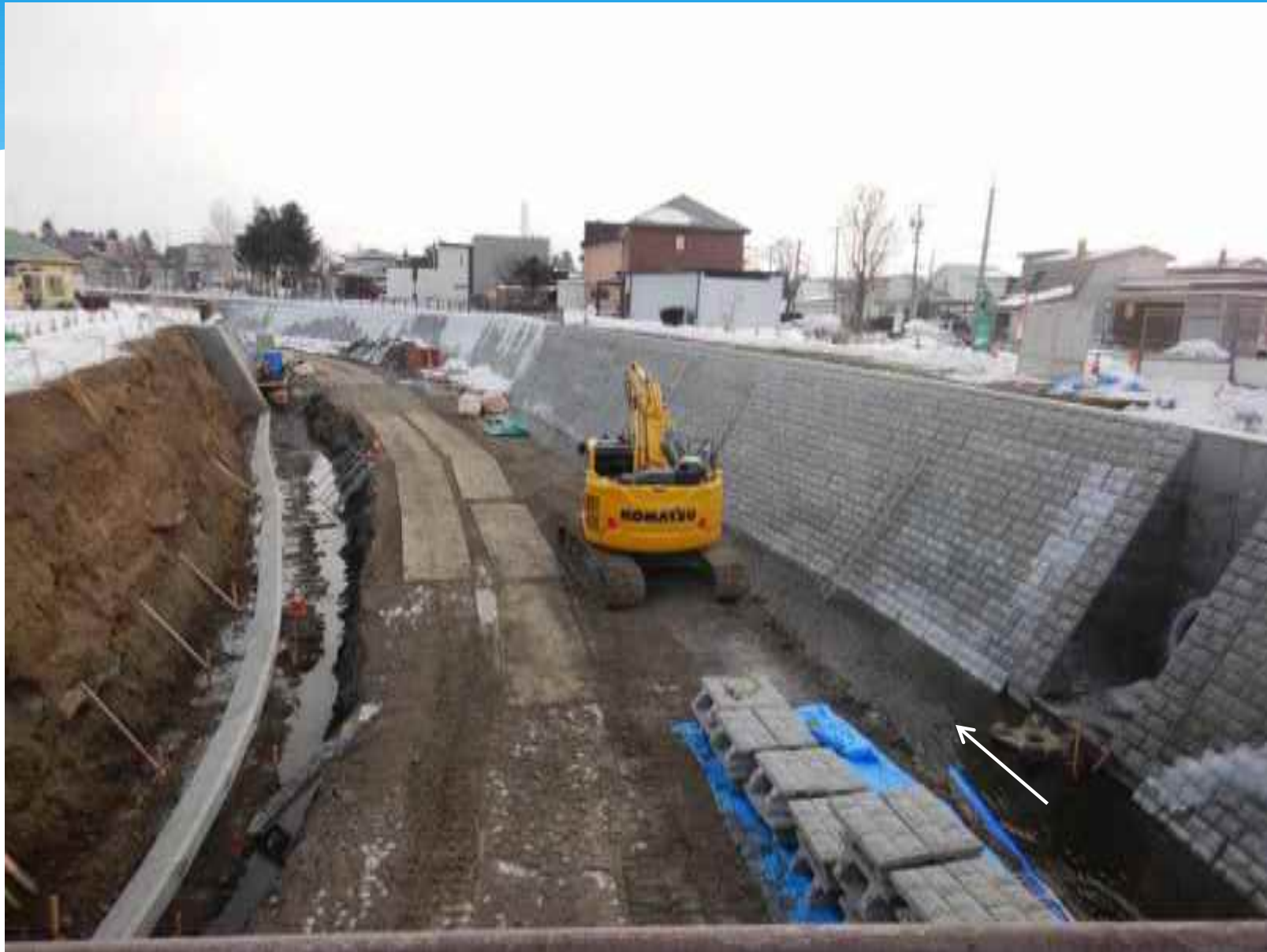
伏古別川での施工状況：北親橋より下流(R2.2.13)
