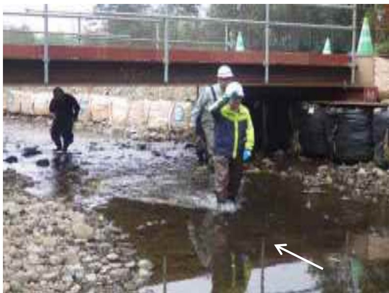
調査風景(11号床固工施工箇所):手前は石垣委員
