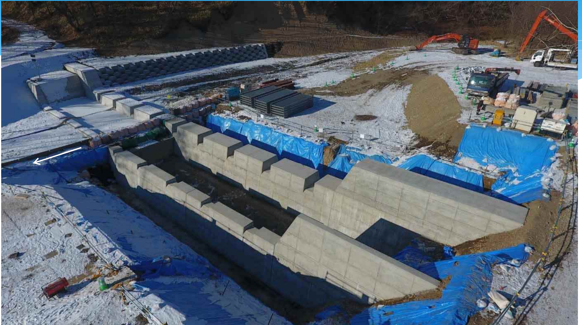
11号床固工 施工状況(R2.2.13)
