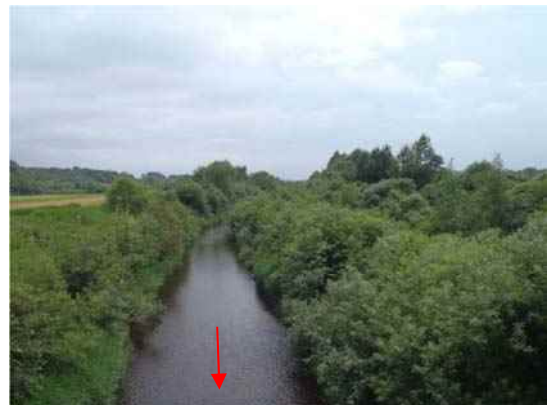
▲南7線橋より上流（中流部）
