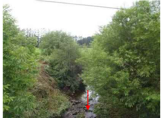
▲更新橋より上流（上流部）
