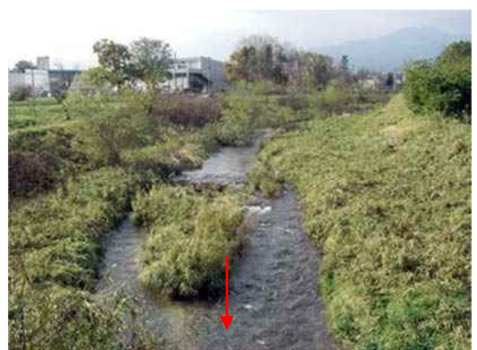
▲神社橋人道橋より上流（下流部）
