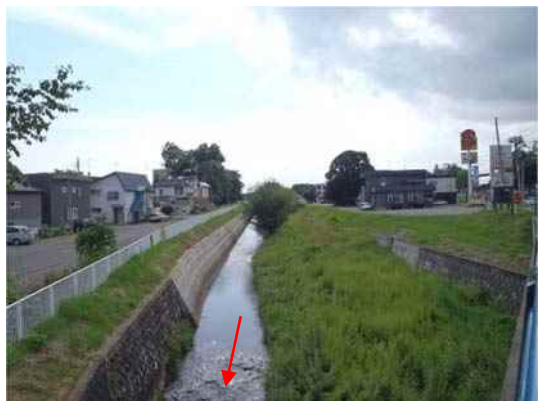
▲蹄橋より上流（下流部）
