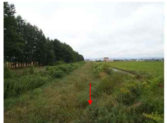
▲更別橋より上流（中流部）
