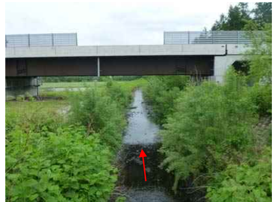
▲第 11 号橋梁より下流（上流部）
