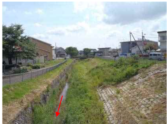
▲善隣橋より上流（中流部）
