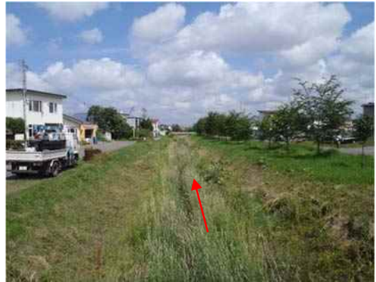
▲南10線橋より下流（上流部）
