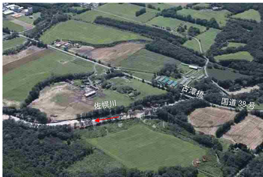
▲古潭橋付近の被災状況 ＜平成28年8月＞
