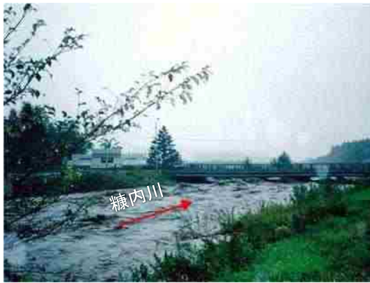
▲万代橋付近の増水状況 ＜平成14年10月＞
