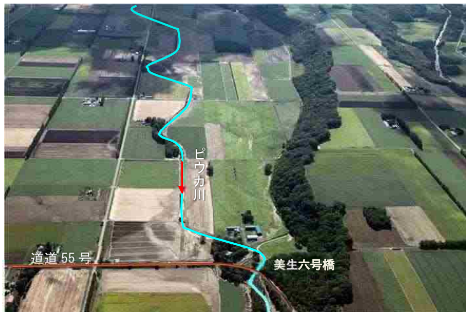
▲美生六号橋付近の被災状況 <平成 28 年 8 月>
