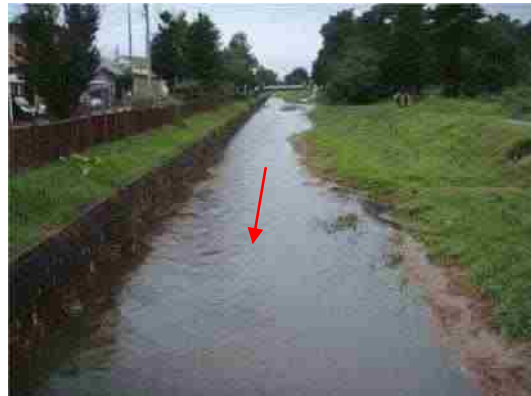
▲広陽橋上流の河川水位上昇 ＜平成23年9月＞
