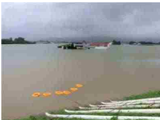
▲農家住宅冠水（相川地区） ＜平成28年8月＞
