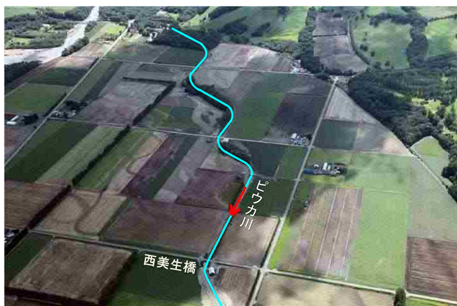
▲西美生橋付近の被災状況 <平成 28 年 8 月>
