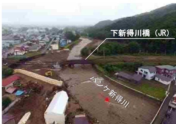
▲鉄道橋付近の被災状況
