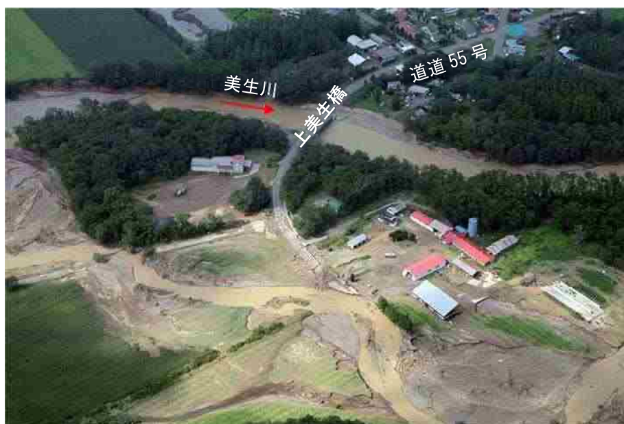
▲上美生橋付近の被災状況 <平成 28 年 8 月>
