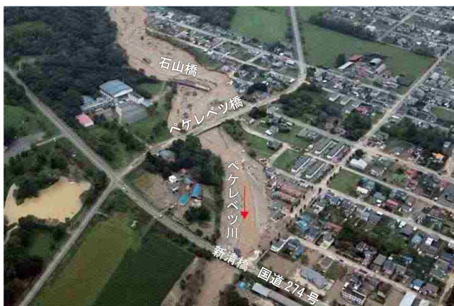
▲石山橋付近の被災状況
