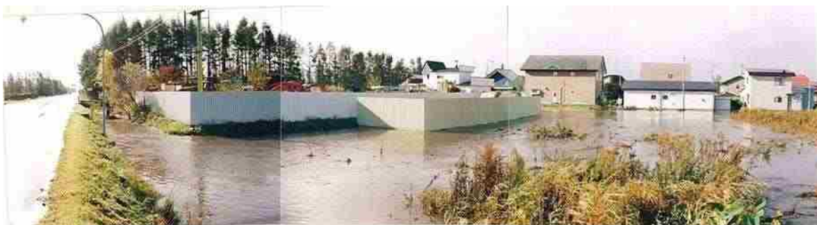
▲更新橋上流約 10m 地点 ＜平成 14 年 10 月＞
