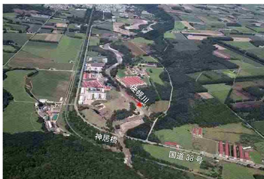
▲神居橋付近の被災状況 ＜平成28年8月＞
