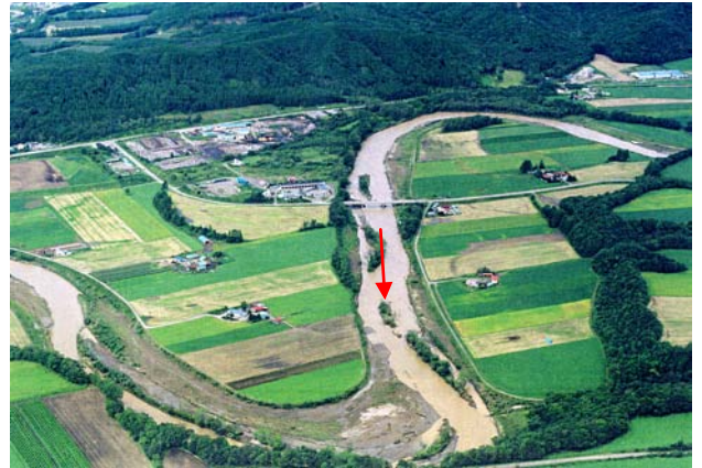
▲足寄川<平成10年8月>
