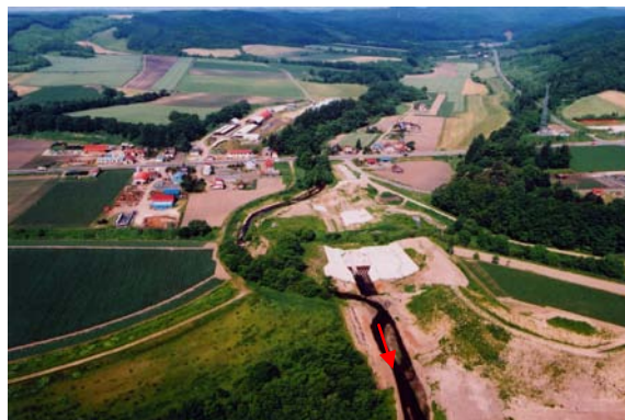
▲ 河川の連続性の復元（魚道付き落差工）
