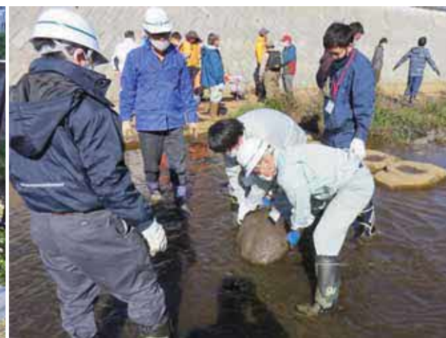
水路内へ大きめの石の配置
