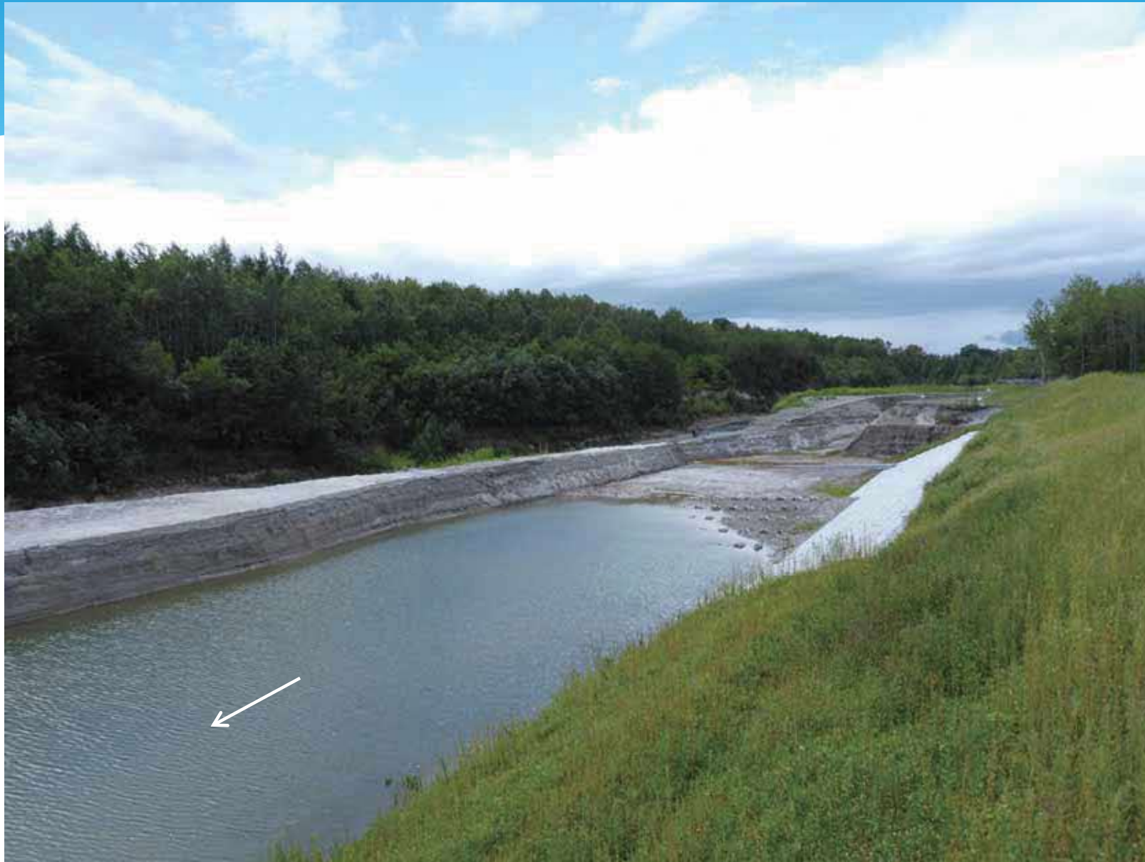
下流側魚道工施工箇所状況 (R2.8.20)
