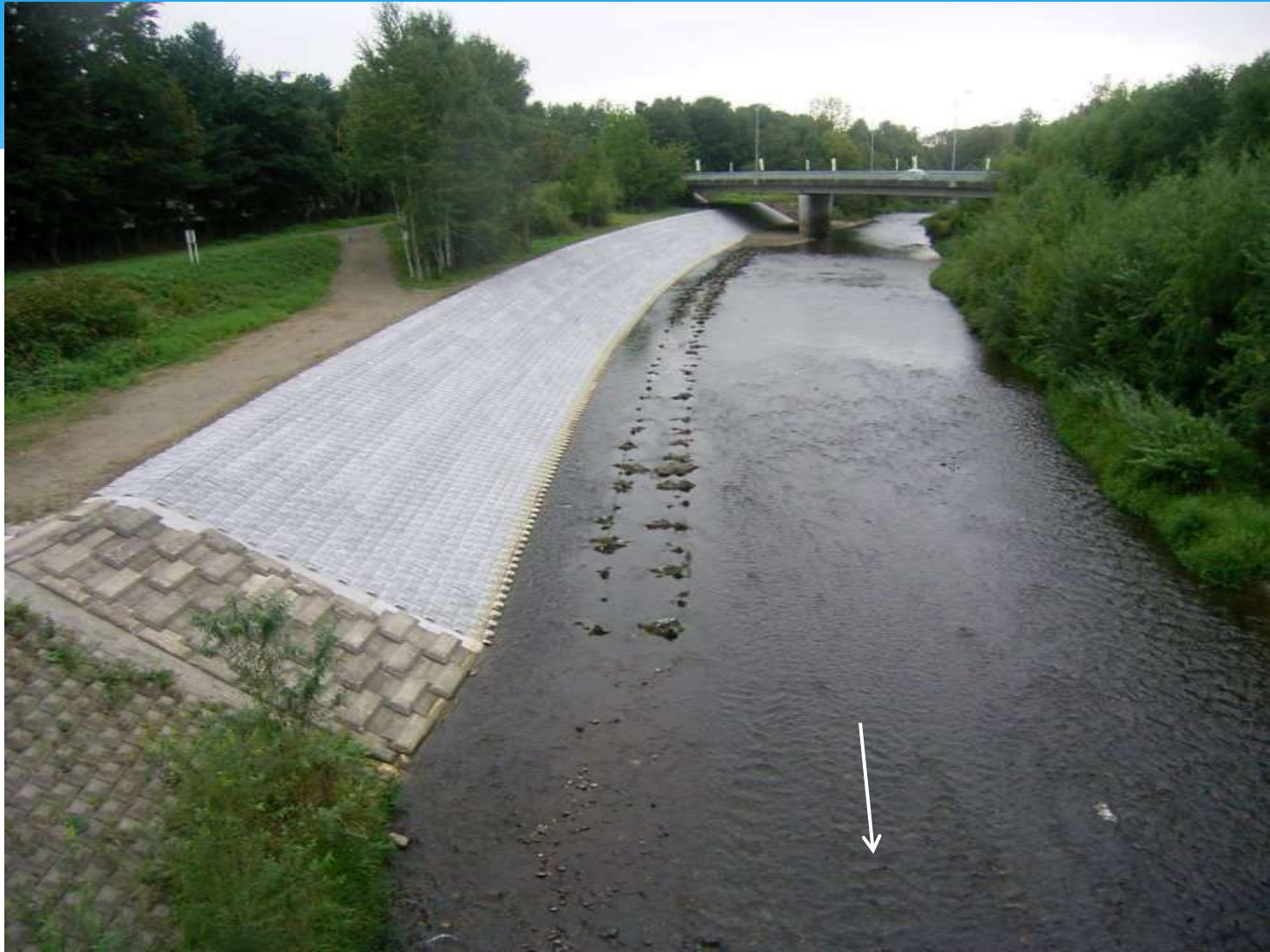
伏古橋上流 施工完了(R1.9.18)
