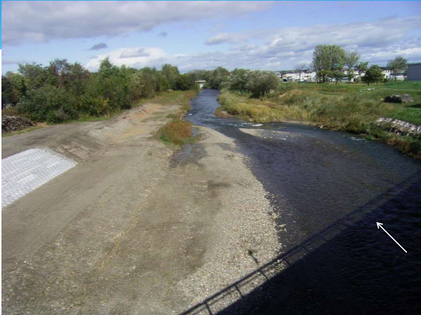
伏古橋下流 施工完了(R1.10.9)
