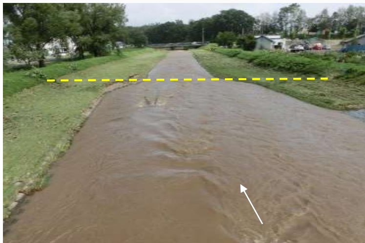
出水状況(芽室町西5条6丁目)H28.8.31
