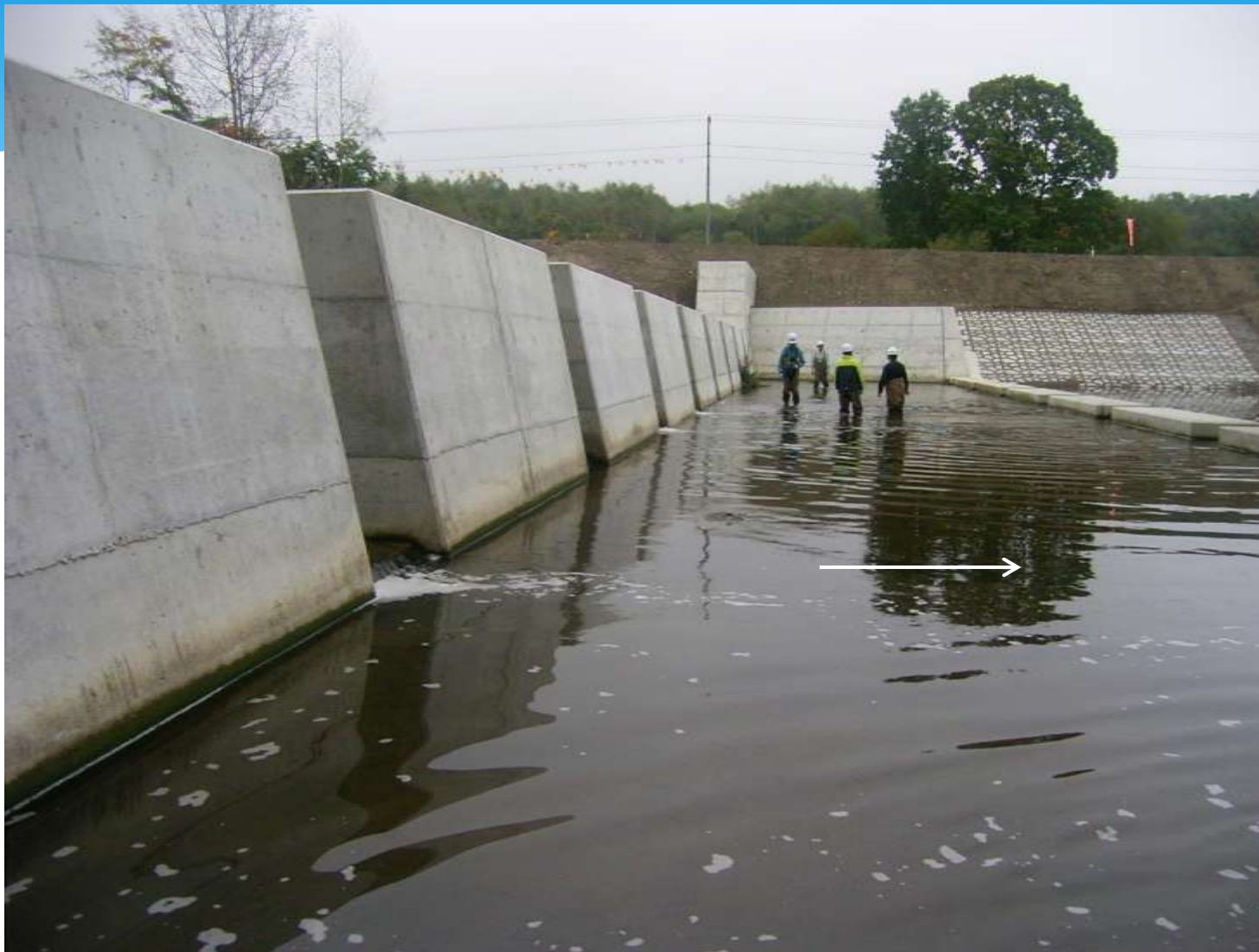
12号床固工 施工完了(R1.10.3)
