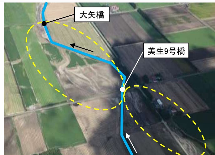
浸水被害状況(芽室町中美生4線)H28.9.7
