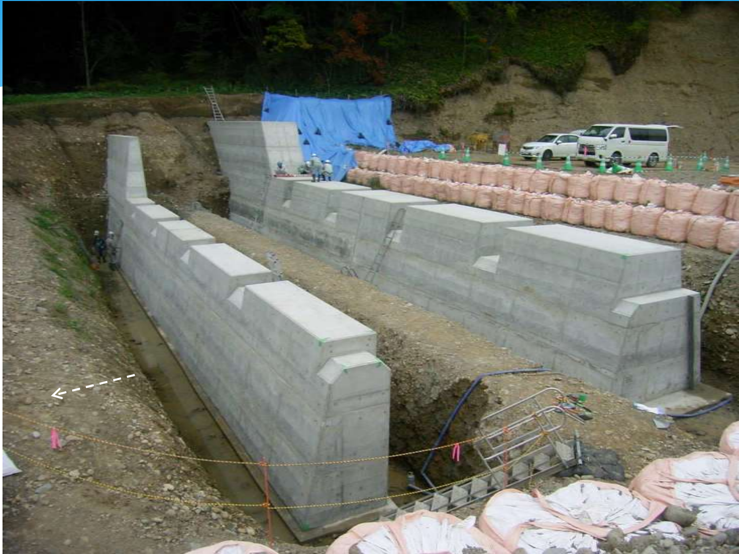
11号床固工 施工状況 (R1.10.3)
