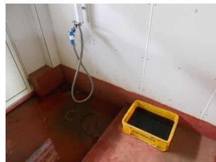
写真2:汚れ落としのシャワーと消毒槽
