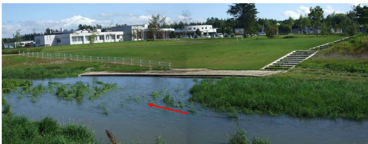
▲サッチャルベツ川に隣接する「福祉の里」と緩傾斜護岸
