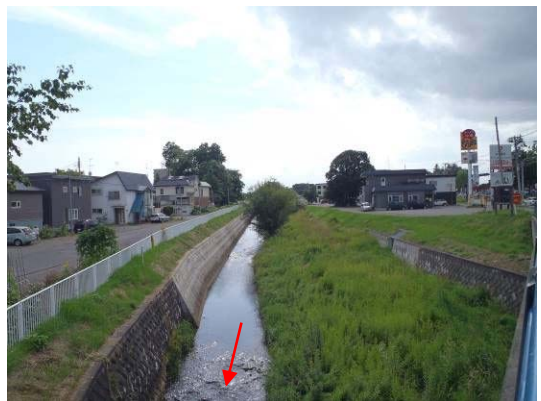
▲蹄橋より上流（下流部）
