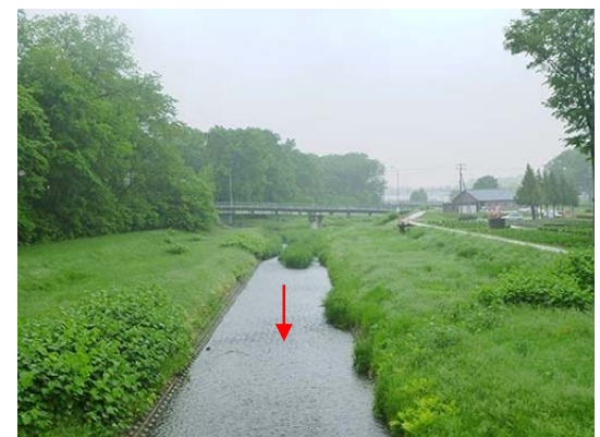
▲芽室公園・柏菖橋より上流（下流部）
