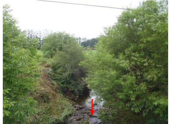
▲更新橋より上流（上流部）
