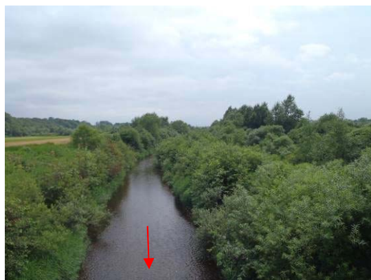
▲ 南7線橋より上流（中流部）
