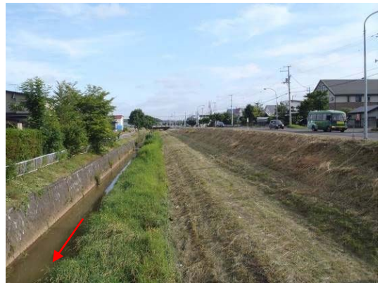
▲ 柏西2号橋より上流（柏林台川）
