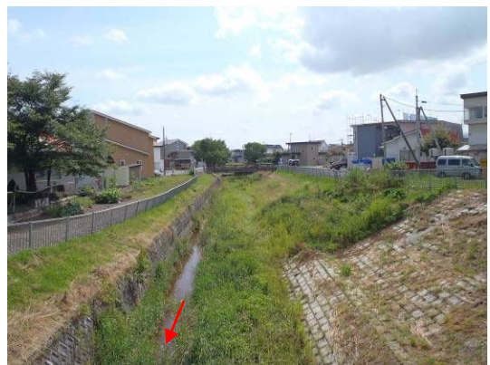
▲善隣橋より上流（中流部）
