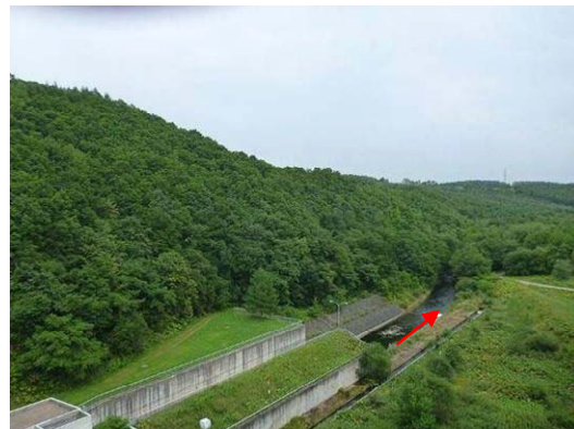
▲佐幌ダムより下流（上流部）
