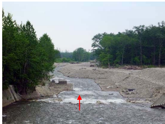
▲旭山橋より下流（上流部）
