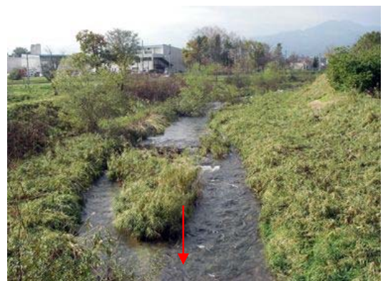
▲神社橋人道橋より上流(下流部)
