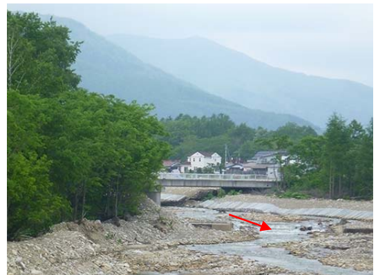
▲新清橋より上流（中流部）
