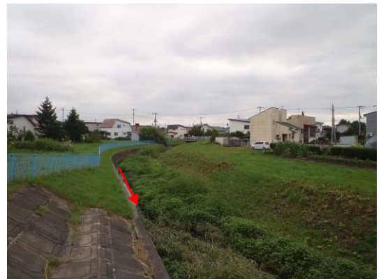
▲伏古別橋より上流
