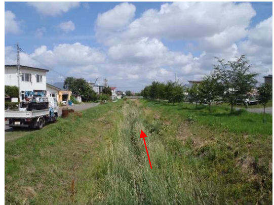
▲南10線橋より下流（上流部）
