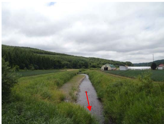
▲茂発谷第二号橋より上流（中流部）
