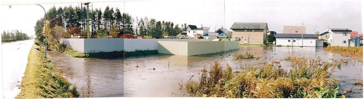
▲更新橋上流約 10m 地点 <平成 14 年 10 月>
