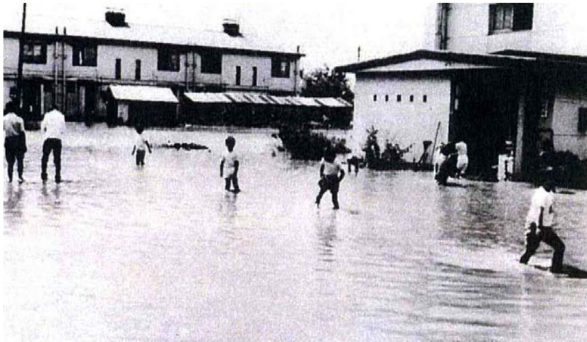
▲西 13 条付近<昭和 50 年 8 月> 出典：水害(北海道開発局、北海道)
