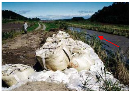
▲茂発谷川第2号橋上流の河岸決壊 ＜平成10年9月16日＞
