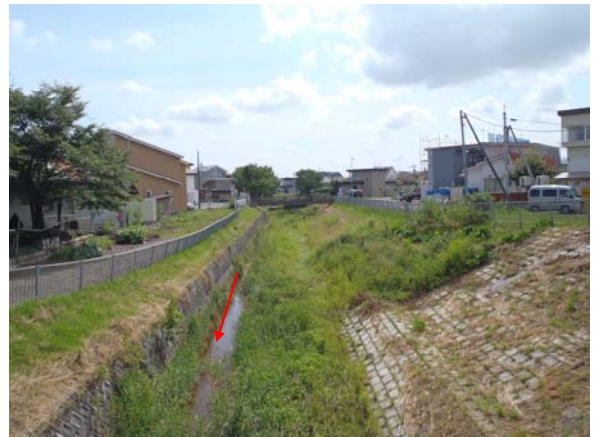
▲善隣橋より上流（中流部）
