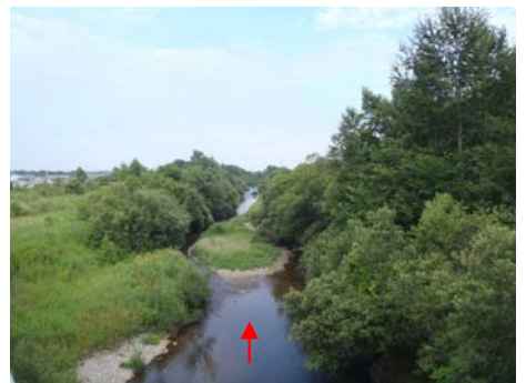
▲新川橋より下流（下流部）
