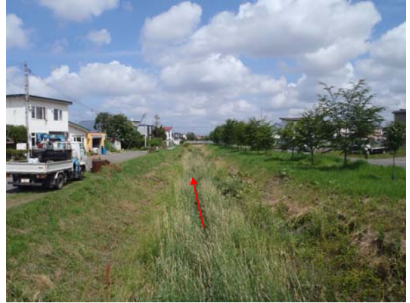
▲南10線橋より下流（上流部）
