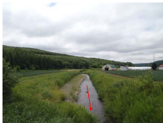
▲茂発谷第二号橋より上流（中流部）
