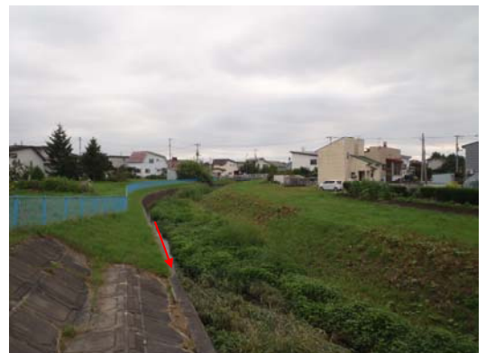
▲伏古別橋より上流
