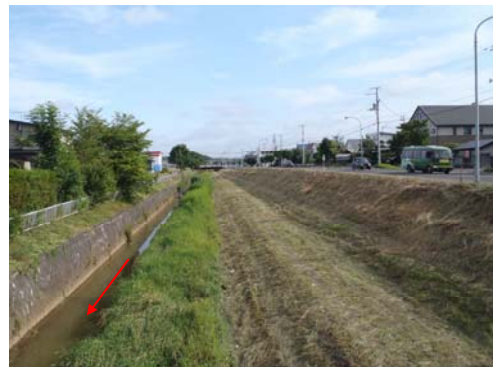
▲柏西 2 号橋より上流（柏林台川）
