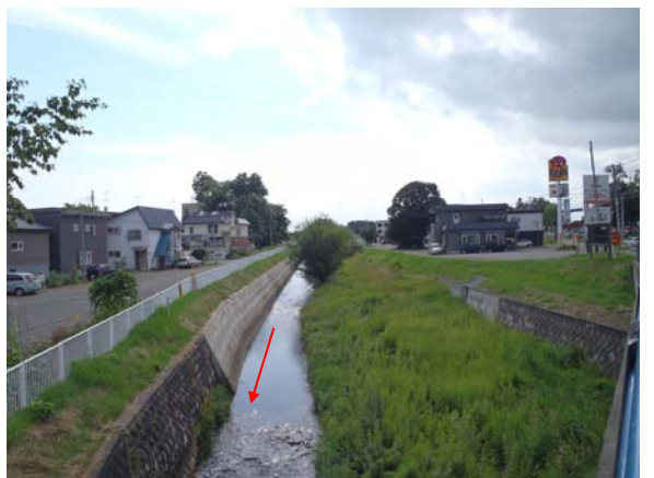
▲蹄橋より上流（下流部）
