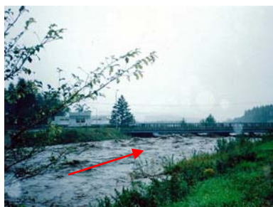
▲万代橋付近の増水状況 ＜平成14年10月＞
