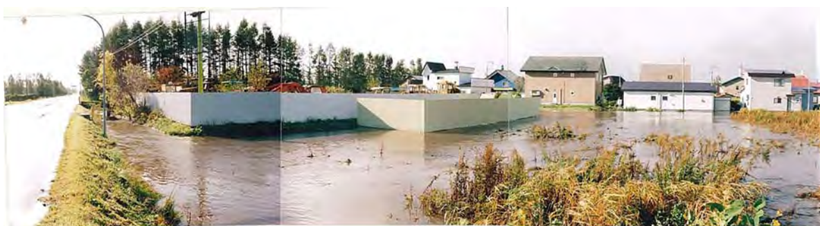
▲更新橋上流約 10m 地点 ＜平成 14 年 10 月＞
