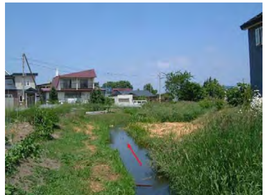
▲住宅地内を貫流（下流部）
