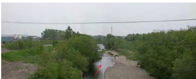
▲新川橋より下流（下流部）
