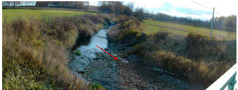
▲更新橋より上流（上流部）
