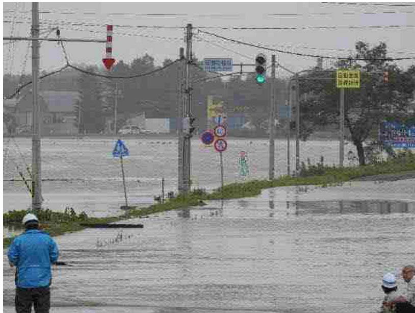
H28.8.31 被災状況(国道38号)
