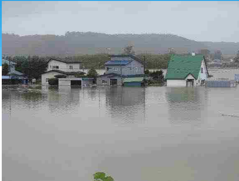
H28.8.31 被災状況
