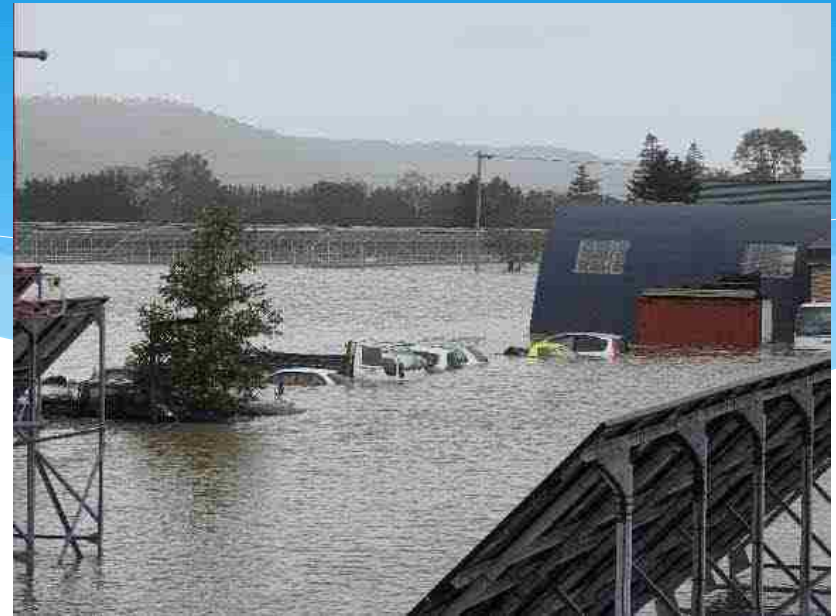
H28.8.31 被災状況
