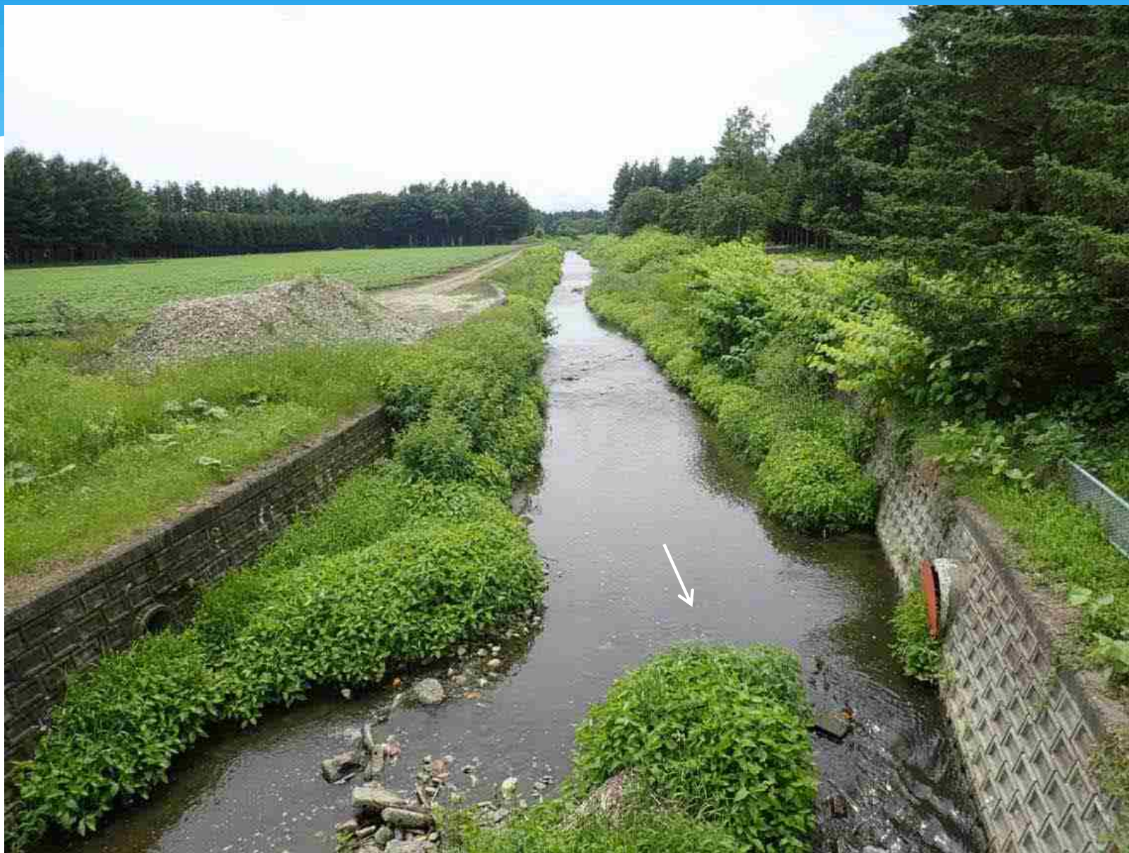
更別橋(国道上流:河道状況(R2.8.28))
