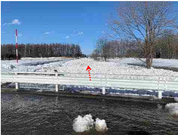
旭南橋 アイスジャムによる氾濫状況 R2.3.11
