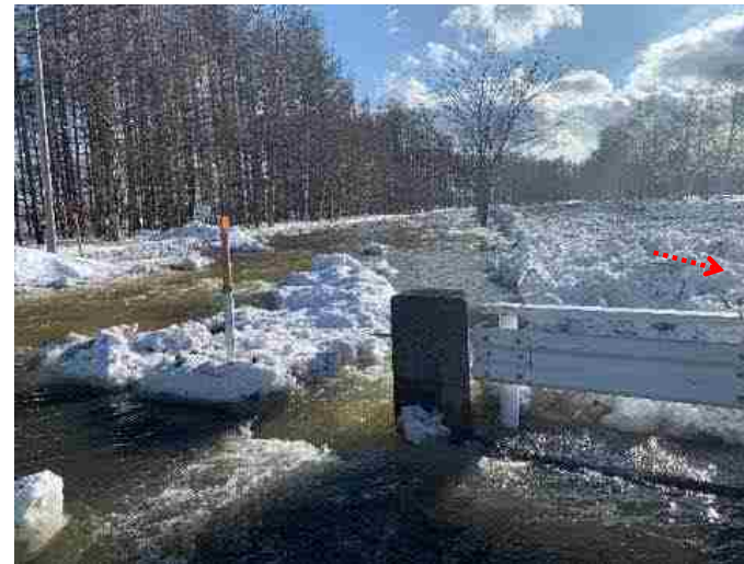
旭南橋 アイスジャムによる氾濫状況 R2.3.11
