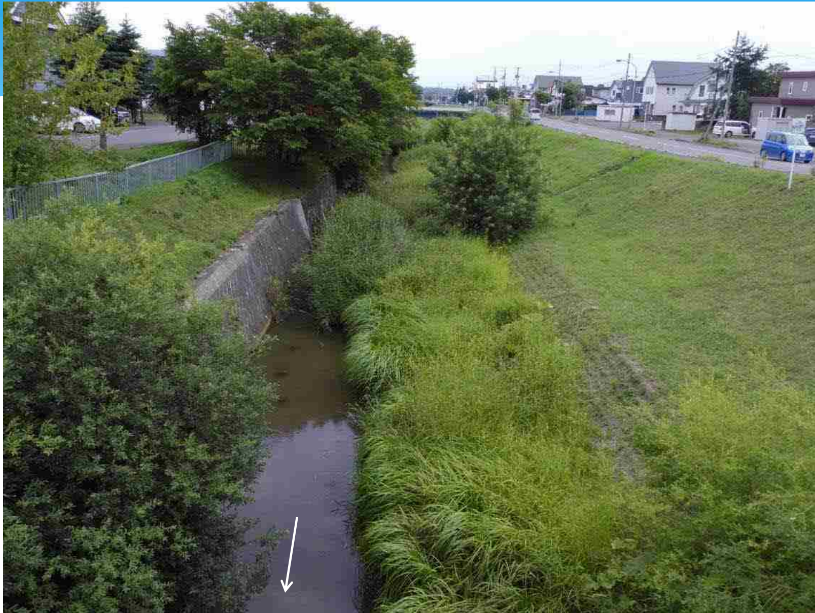
柏西台橋上流：R2年度 施工予定箇所状況(R2.8.4)
