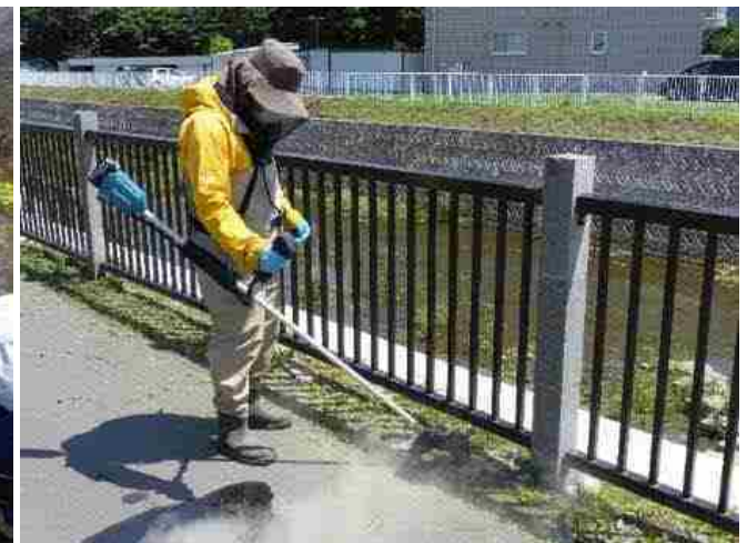
管理用通路沿いの草刈り
