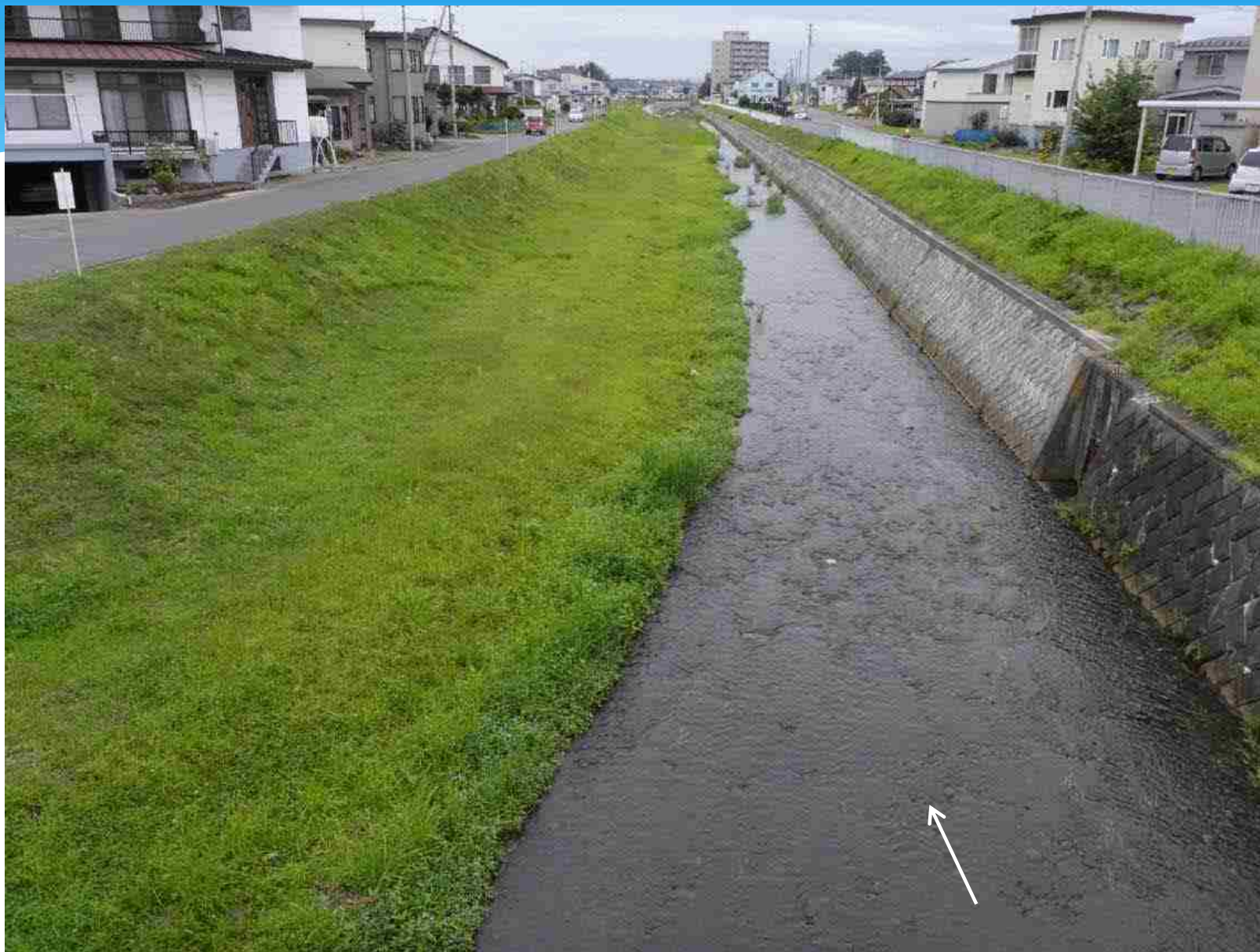
駒追橋下流: R2年度 施工予定箇所状況 (R2.9.2)
