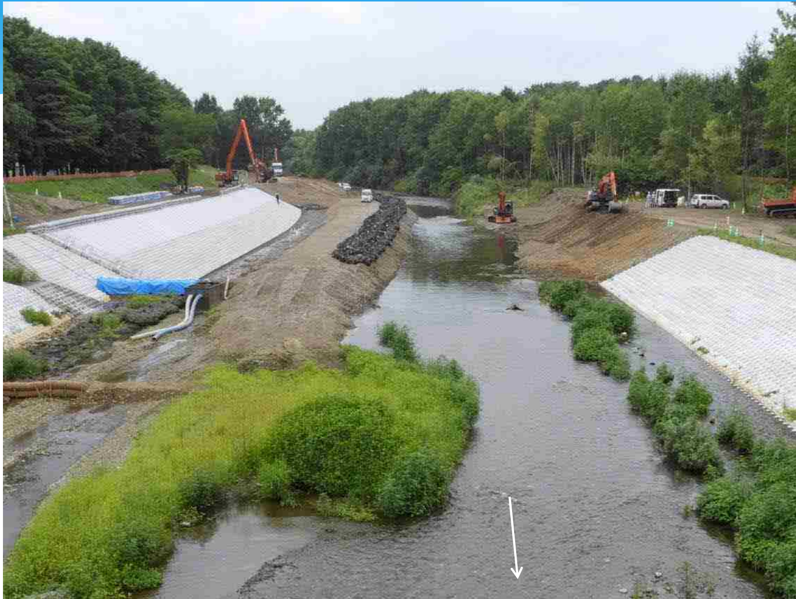
開西橋上流 施工状況 (R2.8.4)
