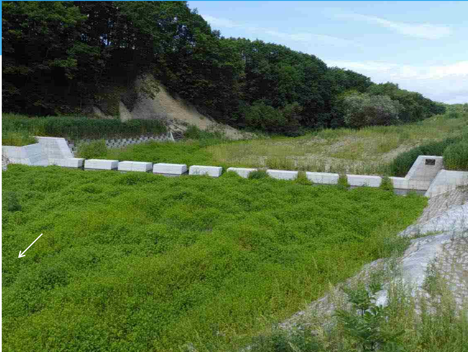
11号床固工 完成状況(R2.8.20)
