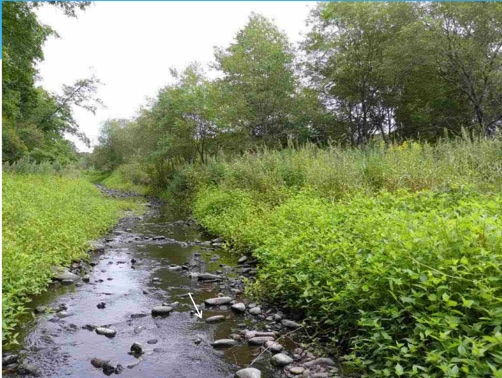
10号床固工 施工予定箇所状況(R2.8.21)
