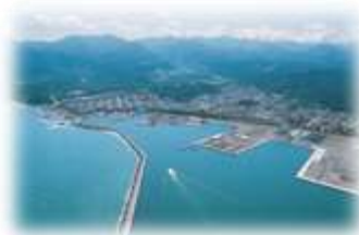
重要港湾「十勝港」(広尾町)
