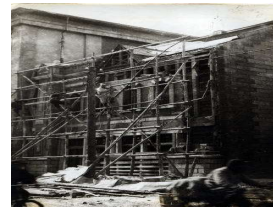
十勝沖地震での被害の様子（昭和27年）
